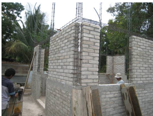
写真3 ソイルセメント造
