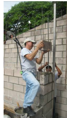
写真2 補強コンクリートブロック造
