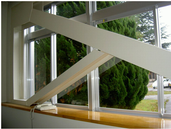
写真 5.12 耐震補強（鉄骨ブレース補強）
