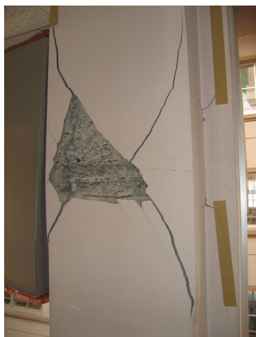
写真 5.20 中庭側の短柱のせん断破壊
