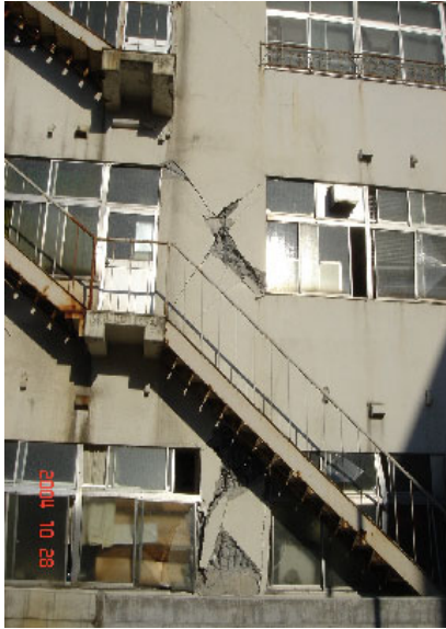
写真 5.6 建築物 C の昭和 43 年竣工棟
