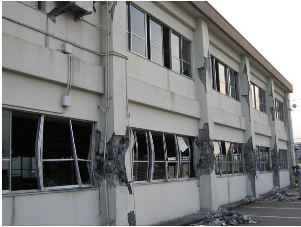
写真 5.4 建物 B (RC 造 2 階建倉庫)
