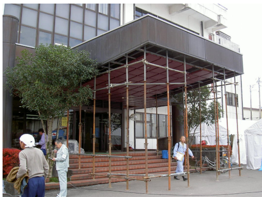
写真 5.38 庇の損傷
