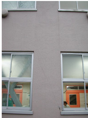
写真 5.27 補強された柱のせん断ひび割れ
