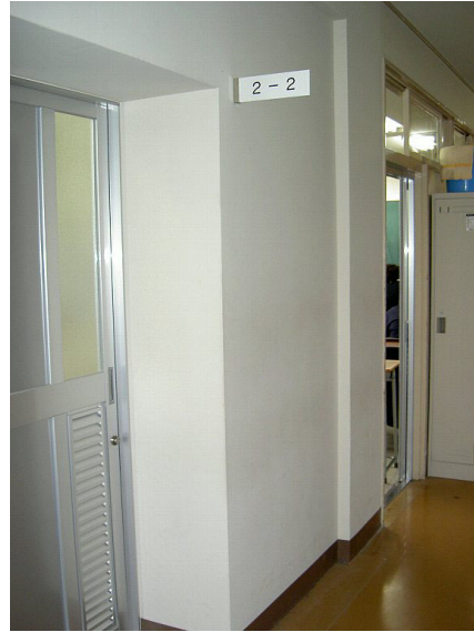
写真 5.13 耐震補強（RC造壁増設）
