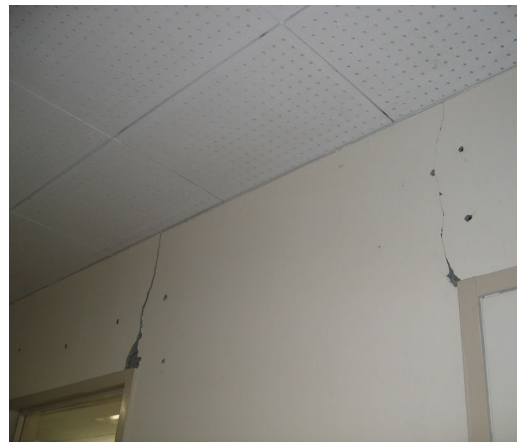
写真 5.9 昭和 44 年竣工棟の梁端の曲げひび割れ
