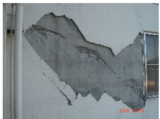
写真 5.9 昭和 44 年竣工棟の梁端の曲げひび割れ
