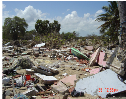
図3.1.6ポイントペドロ東側の被害
