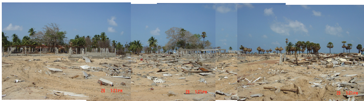
図3.3.1ムライティブ地区での被害
