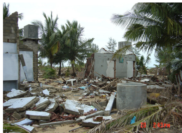
図3.5.6 ラグーン外側の被害
