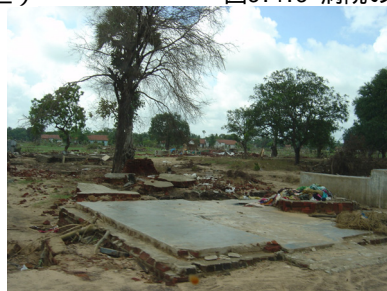
図3.4.5 住家の被害 (キニヤ地区)
