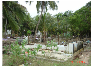
図3.5.8 ラグーン内側の被害
