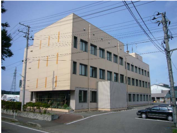
写真7 西山町事務所外観(西から)
