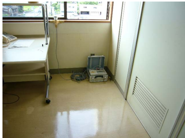
写真10 西山町事務所 3FW 設置状況
