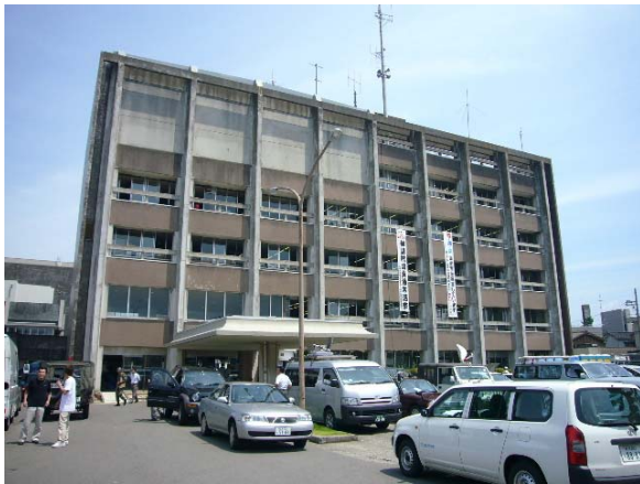
写真1 柏崎市役所本館外観(南から)
