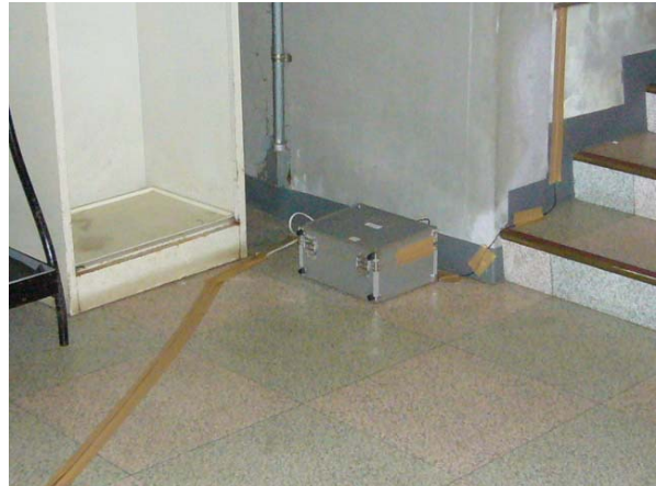
写真6 柏崎市民会館大ホール 1FS 設置状況
