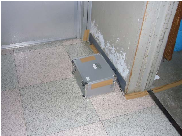
写真5 柏崎市民会館大ホール 1FN 設置状況
