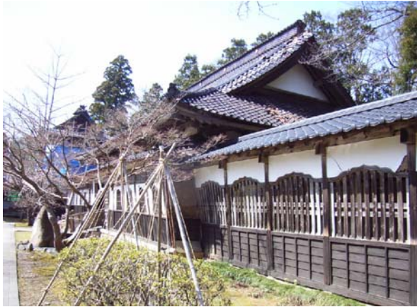
写真 5.19 被害が大きい山門左奥の建物
