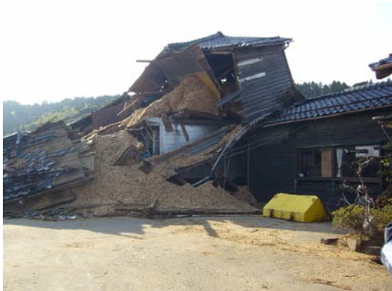
写真 5.1 倒壊したチップ工場
