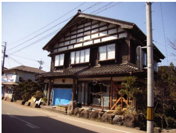
写真 5.23 被害は受けたが残留変形小の民家
