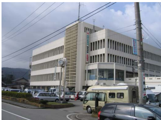
写真 6.1 輪島市役所 (RC造4階建て) (建物無被害、周辺地盤の隆起・ひび割れ)
