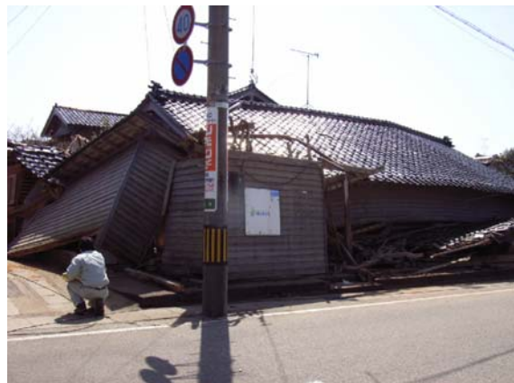
写真 5.26 比較的古い構法の倒壊家屋
