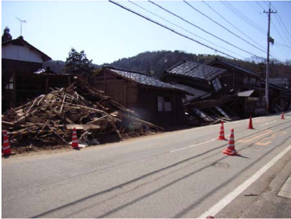
写真 5.13 倒壊家屋が建ち並ぶ駅前地区
