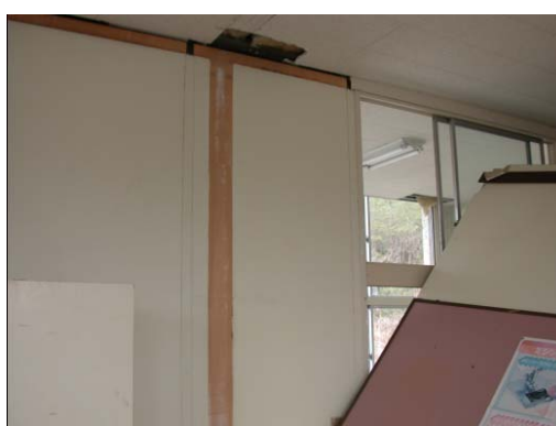
写真 7.7 間仕切り壁の接合部（固定冶具なし）
