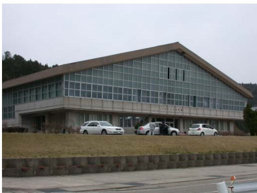
写真 6.13 七尾市中島体育館
