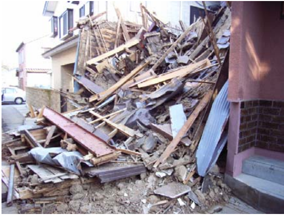
写真 5.3 鳳至地区で選択的に倒壊した家屋
