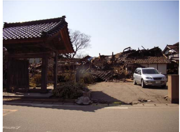
写真 5.20 倒壊して壊滅的な被害を受けた興禅寺
