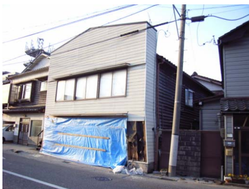
写真 8.2 K-net 輪島 周辺の建物被害
