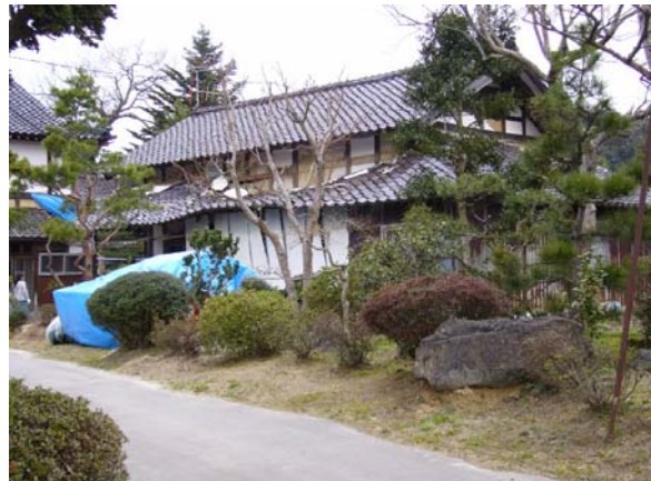
写真 5.52 奥原地区で大破した家屋
