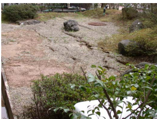
写真 8.8 震度計の周囲の地盤の液状化
