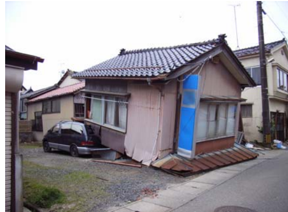
写真 5.40 倒壊し車両をつぶした家屋
