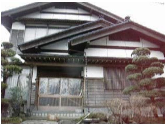
写真 5.43 外観上被害が軽微な建物
