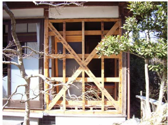
写真 5.24 左の民家の筋かい
