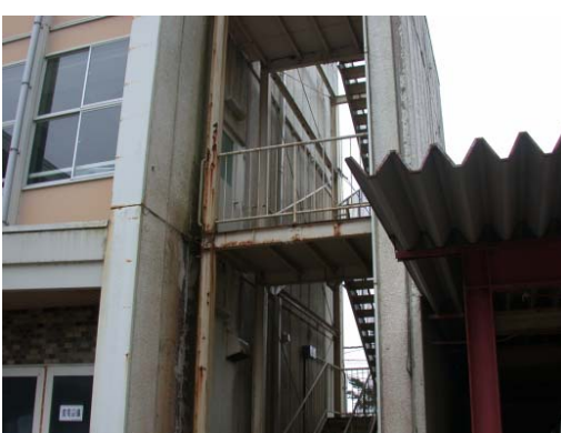
写真 7.9 外部鉄骨階段（前の写真の妻壁反対側）
