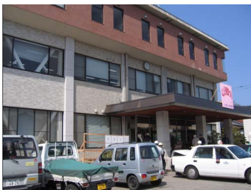
写真 6.3 門前町役場 (RC造3階建て) (建物無被害、周辺地盤の隆起・ひび割れ)
