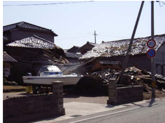
写真 5.34 倒壊した納屋又は倉庫
