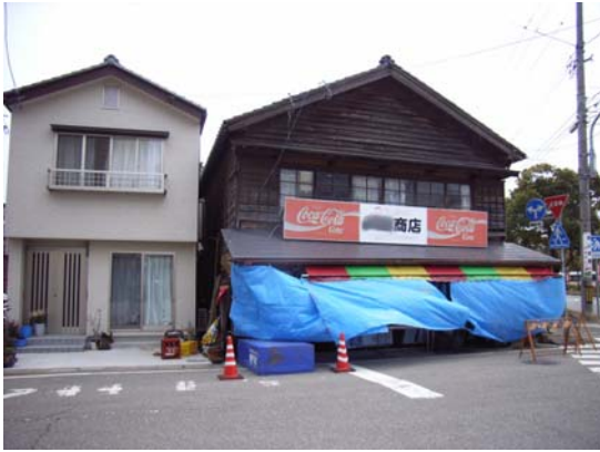
写真 5.39 倒壊した店舗
