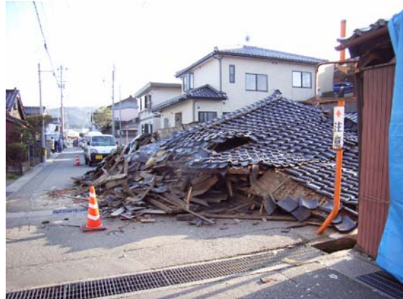
写真 5.8 道路をふさぐ倒壊例
