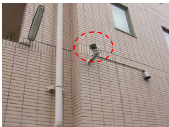
図-5.4.34 防犯カメラ（免震部分に固定され、周囲敷地を撮影する1台）
