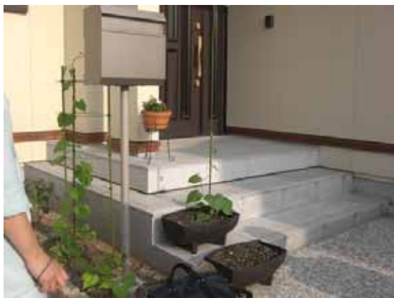
(a) 玄関付近（変状なし）
