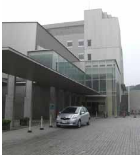
図-5.4.25 D 建築物（RC造6階建て）
