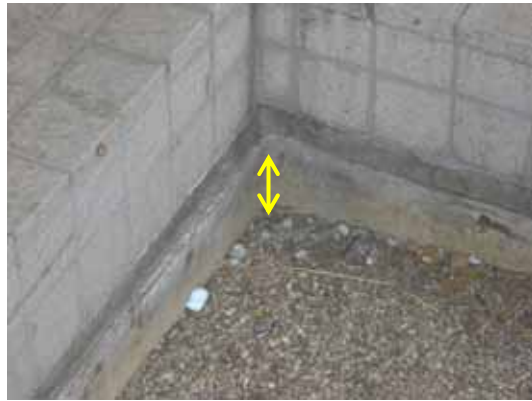
(b) 立上り部の露出（最大5 cm程度）
