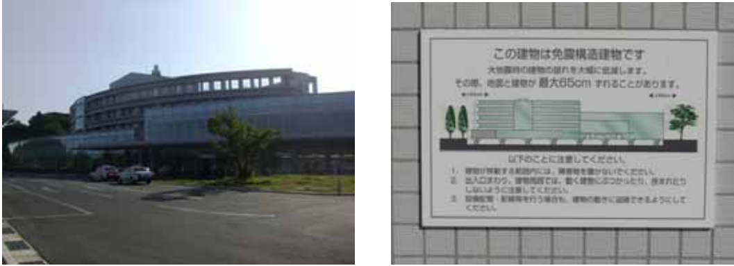
(a) 建築物外観（I棟） (b) 免震であることの表示（最大変位65cm）
