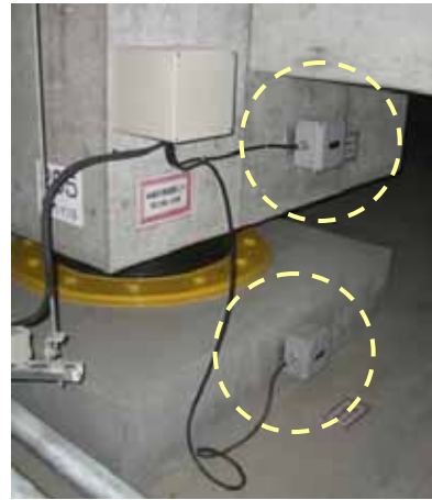
(b) 免震層内
