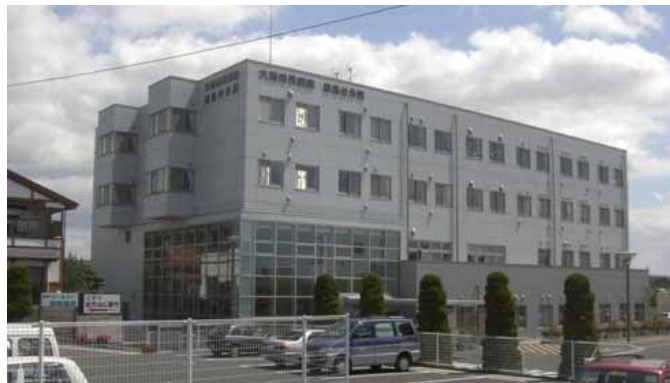
図-5.4.1 A建築物（RC造4階建て）
