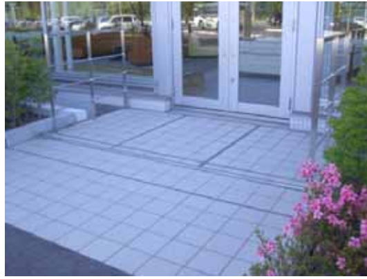
図-5.4.22 I棟南東側出入口エキスパンション（無被害）
