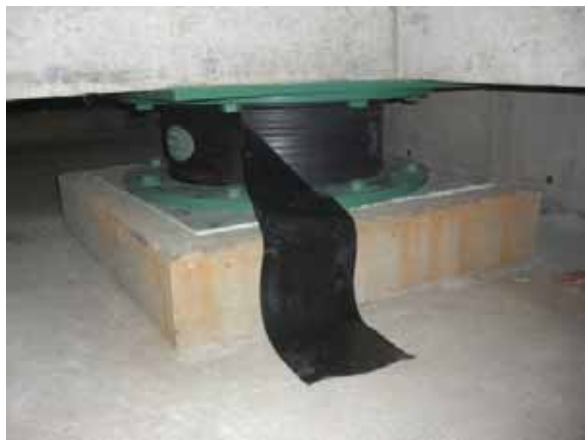
(d) 積層ゴム支承及びカバー脱落 (本震直後の点検時の状況を再現したもの)
