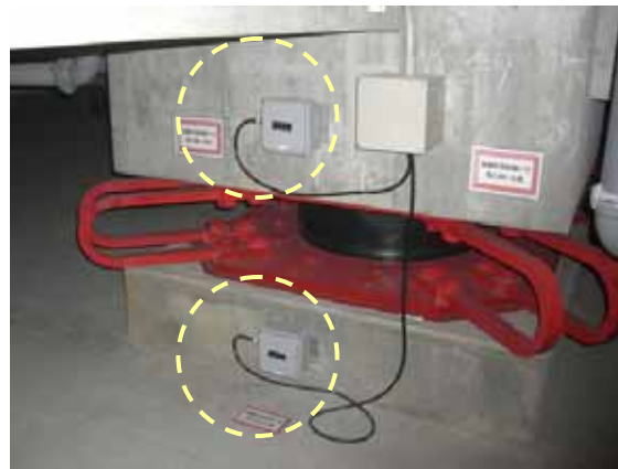
(b) 免震層内
