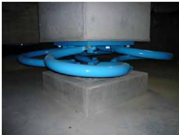
図-5.4.32 鋼棒ダンパー
