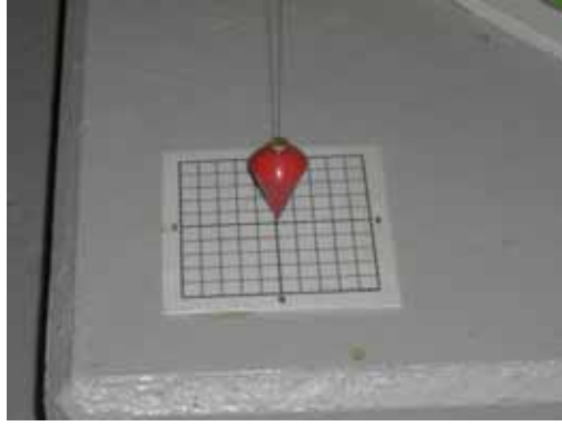
図-5.4.26 下げ振り設置状況（積層ゴム台座部分）
