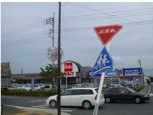
写真 30 道路標識の折損
