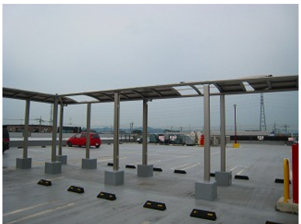
写真5 屋上駐車場の歩行者用通路上の屋根
