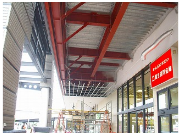
写真3 1階店舗入口の軒天井仕上げ材の撤去状況
