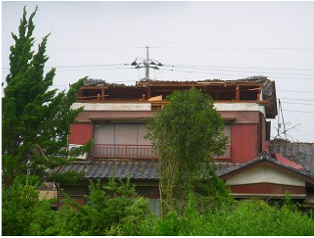
写真 21 小屋組の倒壊（西からみる）
