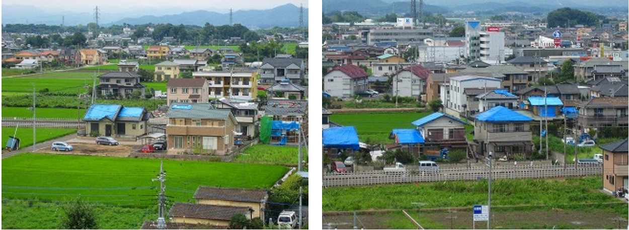
写真1 屋根を覆ったブルーシートの分布状況
