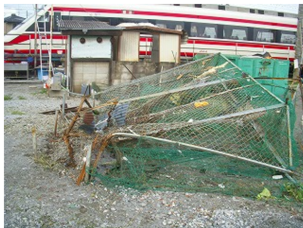
写真 20 フェンスの著しい変形
