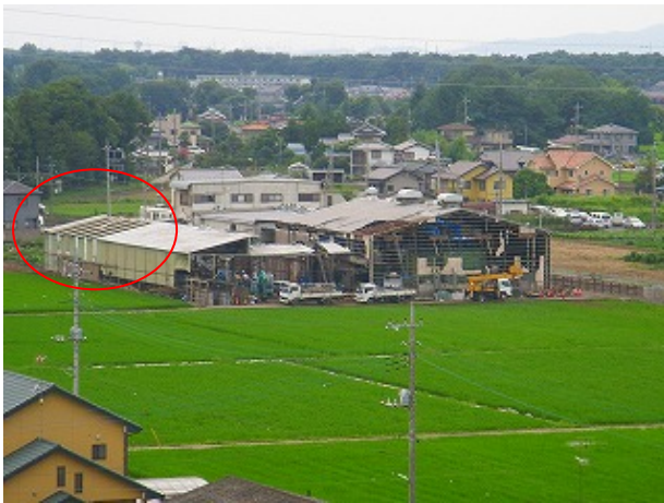
写真8 被害状況の遠景（南東からみる）
