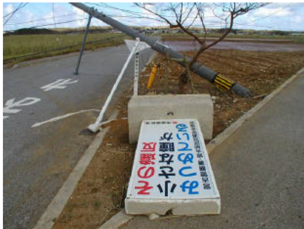
写真 64 看板等の転倒及び折損（平良城辺線沿い）
