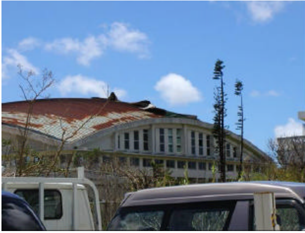
写真9 体育館の概観（北からみる）
