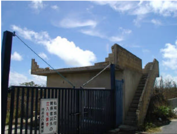
写真 47 ブロック塀の被害（平良市狩俣地区 1）
