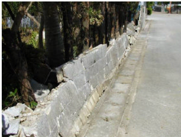
写真 47 ブロック塀の被害（平良市狩俣地区 1）
