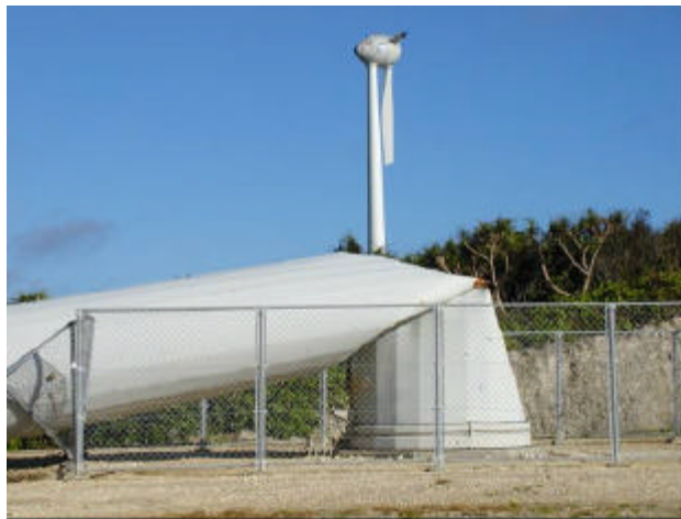
写真 54 5号機の倒壊（南からみる）
