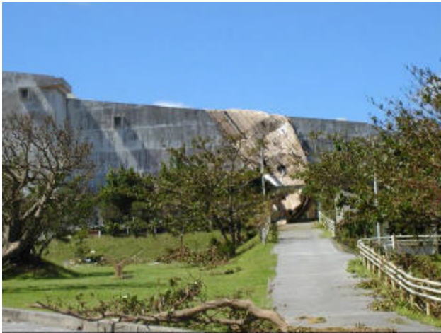
写真11 平良市立中央公民館の概観（北東からみる）
