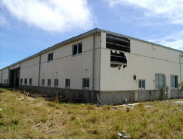
写真 43 重機用格納庫の概観（北からみる）
