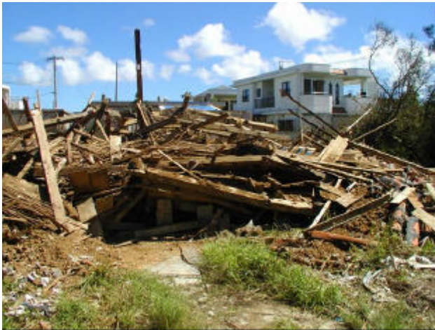
写真 24 木造住宅の倒壊
