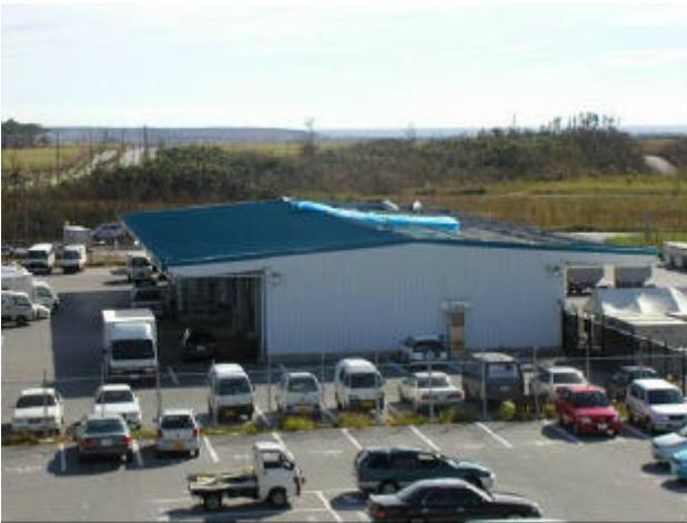
写真 39 宮古空港内貨物庫の概観（北東からみる）
