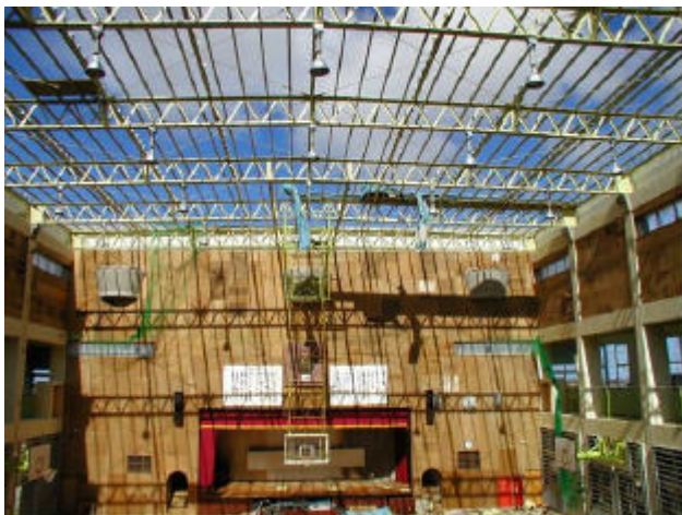
写真 19 体育館内部の概観
