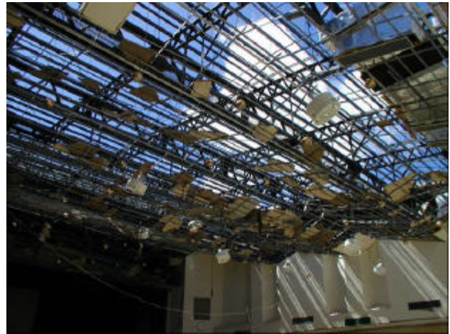
写真12 大ホール内の鉄骨造による屋根骨組
