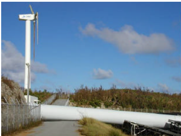
写真 59 宮古太陽光発電実証施設の概観（西からみる）
