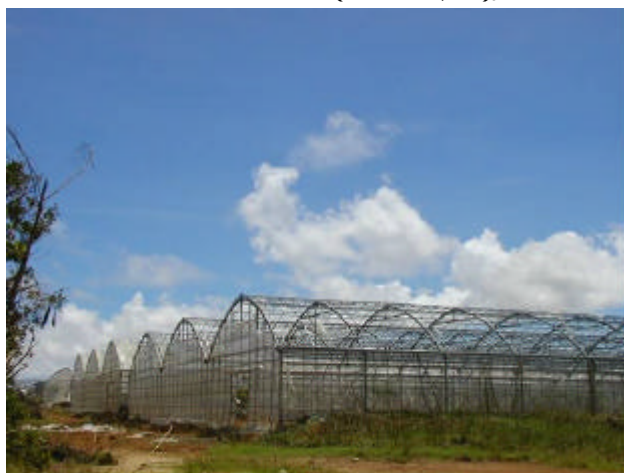
写真 66 ビニールハウスの被害 2（平良市西原地区）
