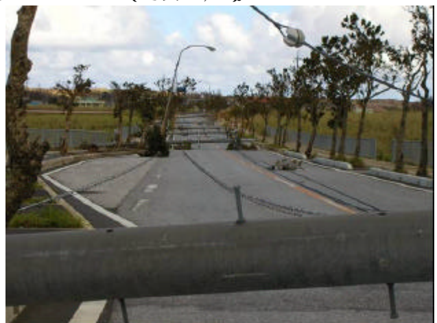
写真 52 平良城辺線沿いの電柱の折損 2
