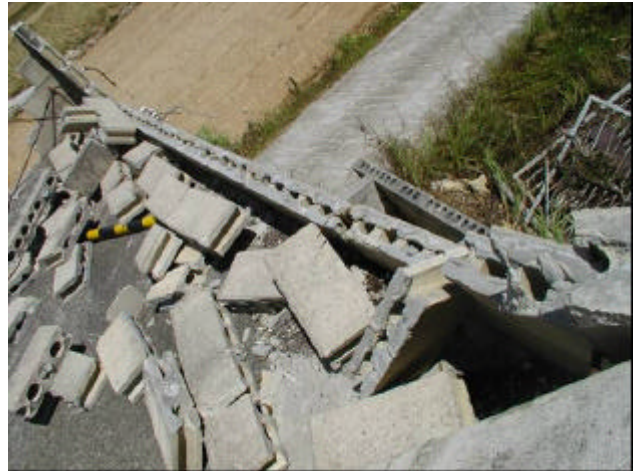
写真 48 ブロック塀の被害（平良市狩俣地区 2）
