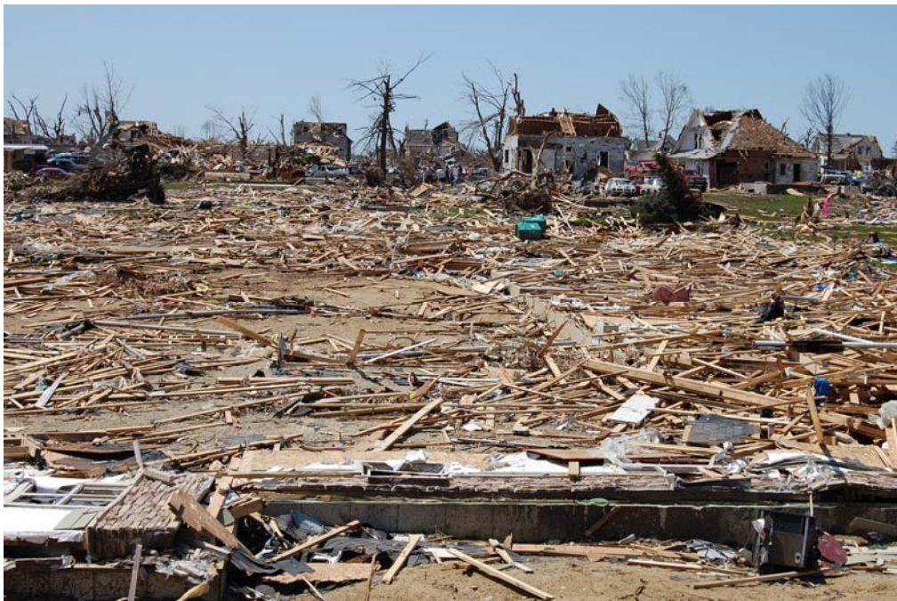
写真2 多数飛散した住宅の枠組材等（西方向を撮影）
