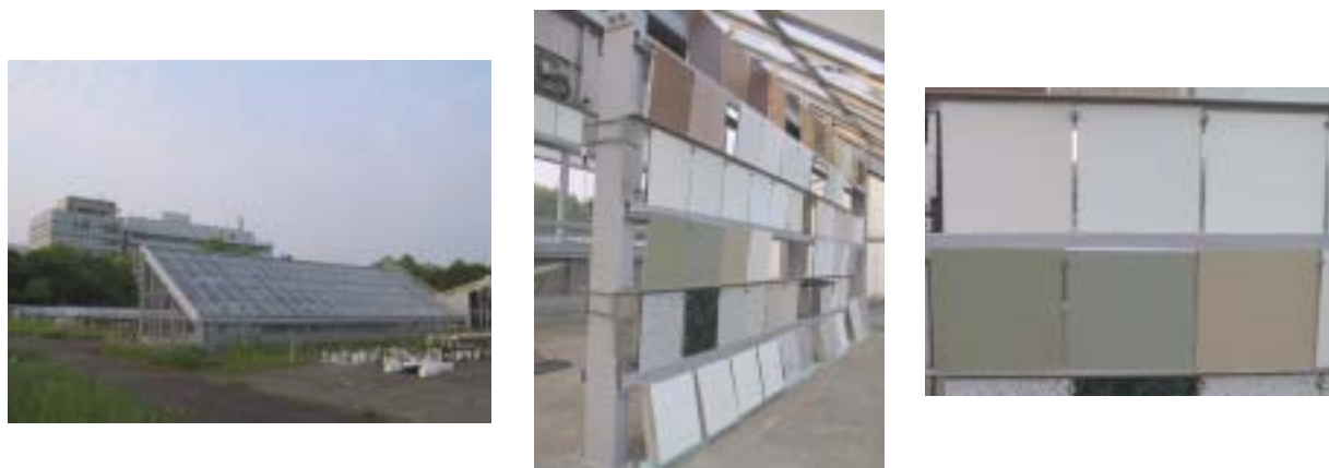
図 暴露試験実施状況（左から屋内環境ばくろ棟全景、試験体設置状況、試験体外観）
