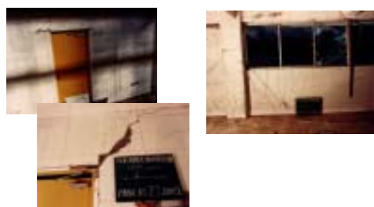
写真 2 RC 造実大構造物の破壊実験と損傷状況
