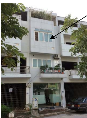
ベトナム、ハノイのローハウス（中層の長屋形式の住宅、全世帯の 82%を占める）
