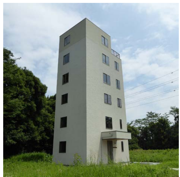
図4 枠組壁工法6階建て実大実験棟
