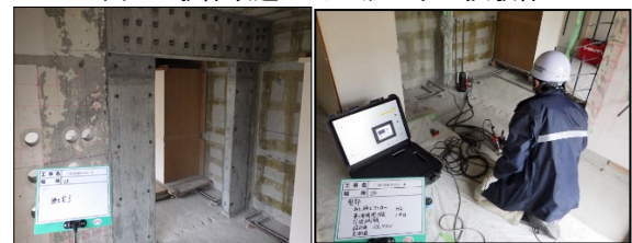
図4 躯体改造した実建物とアンカー引張試験
