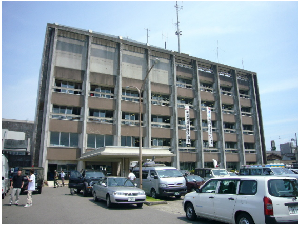
写真-3.1 柏崎市役所本館外観(南から)
