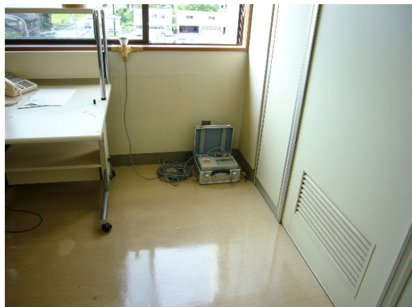
写真-3.10 西山町事務所 3FW 設置状況
