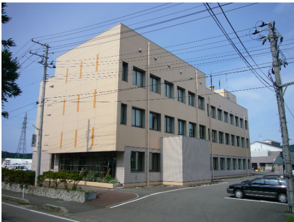
写真-3.7 西山町事務所外観(西から)
