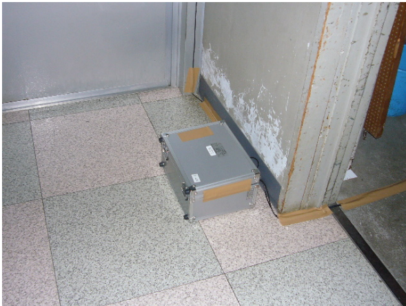
写真-3.5 柏崎市民会館大ホール 1FN 設置状況
