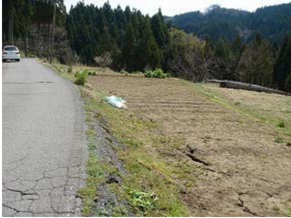
D-c 中腹部の開口亀裂
