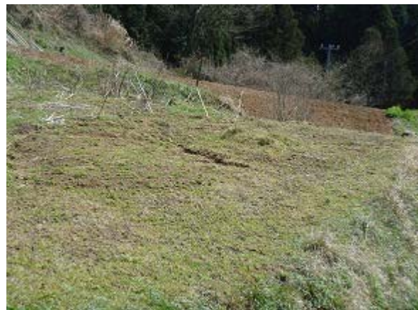
D-b 斜面上部の開口亀裂
