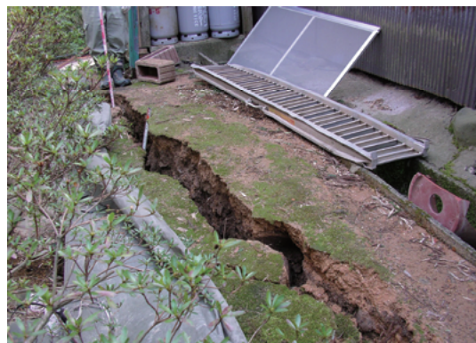
写真-3.3.6 家屋周辺の開口亀裂
