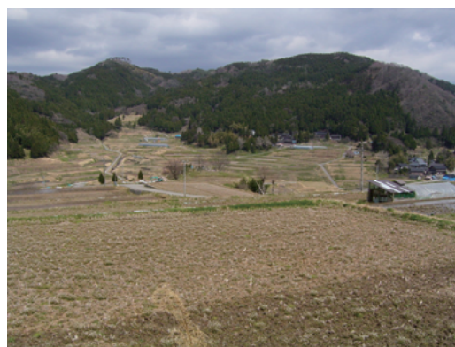
写真-3.3.5 坂尻地すべり全景
