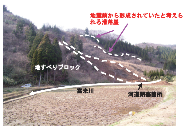
写真-3.3.18 地保地すべりの全景
