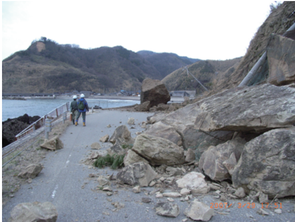
写真-3.2.3 海岸部の落石と尾根直下からの崩壊（写真左上の斜面）（輪島市門前町深見）
