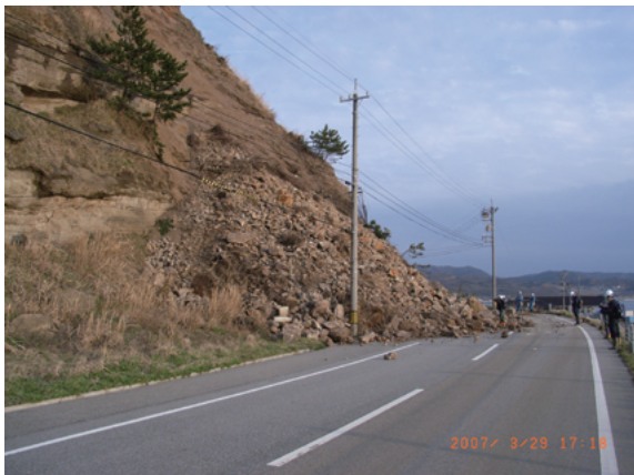
写真-3.2.1 海岸部の崩壊 (輪島市門前町深見)
