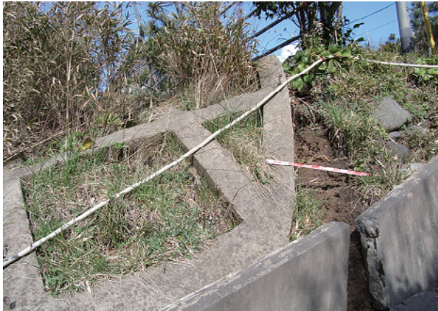
写真-3.2.12 のり枠工の変位 (約 40cm)
