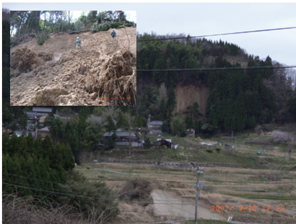
写真-3.2.5 内陸部の崩壊 （輪島市門前町椎）
