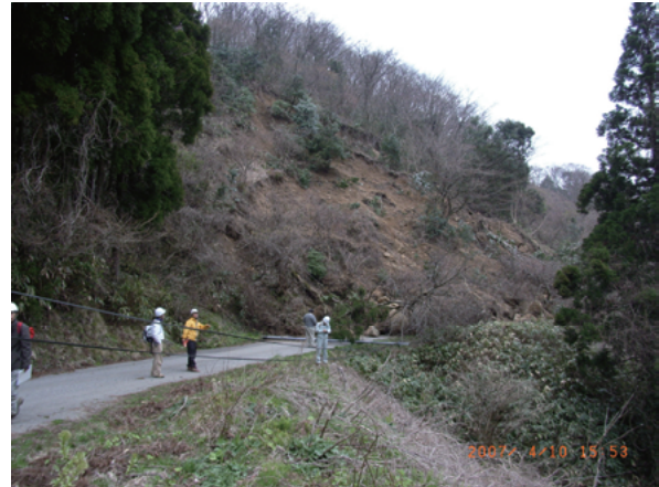
写真-3.2.4 内陸部の崩壊 （輪島市門前町尺ヶ池）
