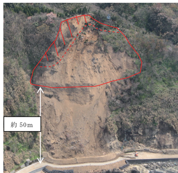
写真-3.3.2 地すべり発生後の斜面の状況 (写真提供：輪島市)
