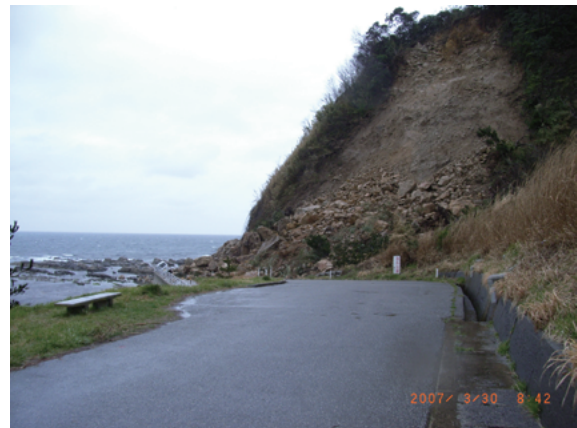
写真-3.2.2 海岸部の崩壊 (輪島市竜ヶ崎)
