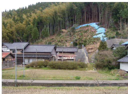
写真-3.3.12 栃木地すべり全景
