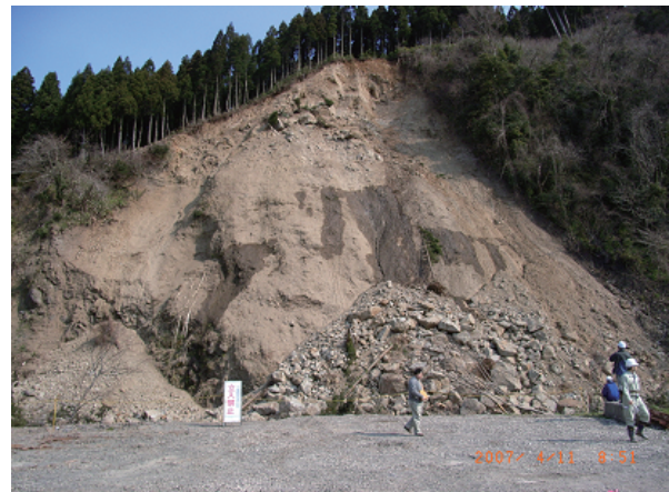
写真-3.2.6 内陸部の崩壊 （輪島市熊野）
