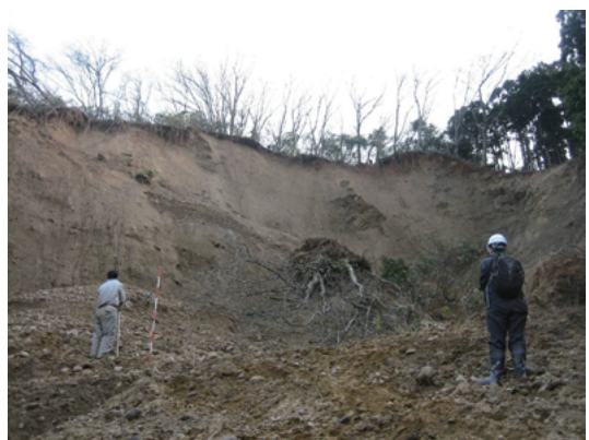
写真-3.2.8 尺ヶ池地区の崩壊地
