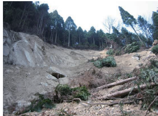
写真-3.2.7 中野屋地区の崩壊
