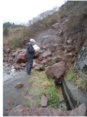
写真-3.3.16 排水トンネル 流末の状況
