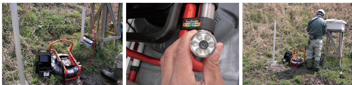
写真-3.3.9 ボアホールカメラによるボーリング孔内の変状観察
