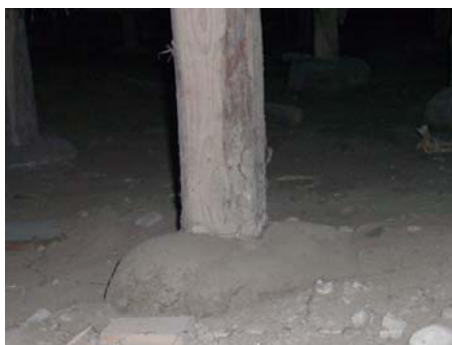
写真-10.6.3 土台基礎やブロック基礎を用いた住宅の建物内部の束基礎
