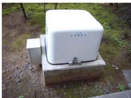
写真-10.4.7 門前総合支所裏庭の石川県震度計
