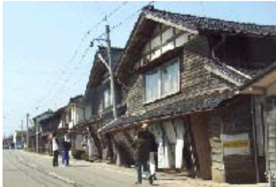
写真-10.4.11 道下地区で道路側へ傾く家屋群
