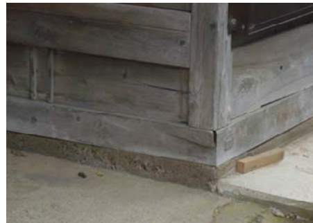
写真-10.6.1 地上での立ち上がり部分がほとんどない古い土台基礎 (地表面付近に切石などを設け、地表面から数 cm ほど上部に木質土台を置く基礎形式)
