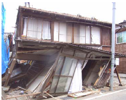
写真-10.4.15 倒壊寸前の店舗併用住宅
