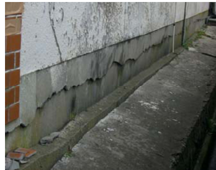
写真-10.6.5 ブロック基礎の被害例 (外周をモルタル等で覆って無筋コンクリートと区別が難しい場合もある)
