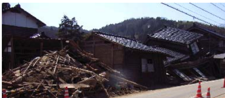
写真-10.4.8 門前地区で軒並み倒壊する家屋群
