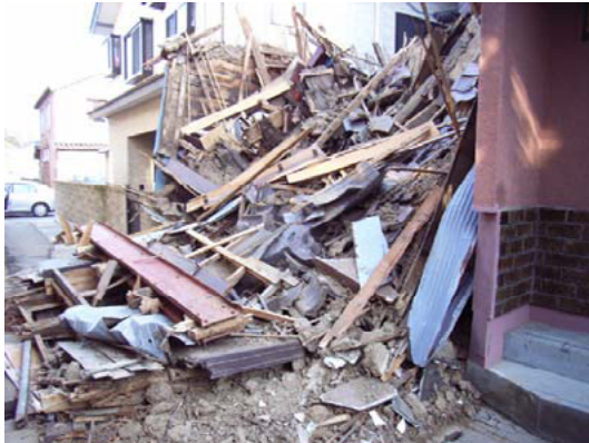
写真-10.4.1 選択的に倒壊した比較的古い構法の家屋
