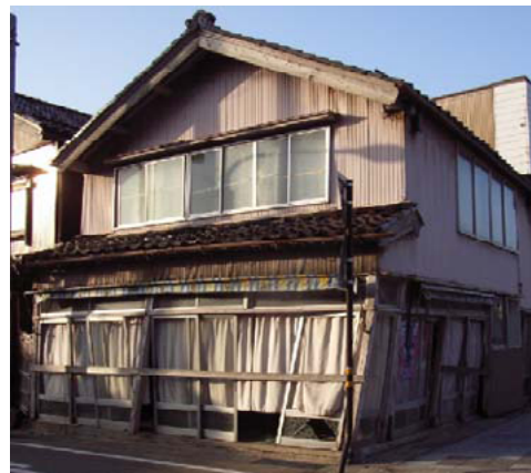
写真-10.4.3 大きな被害を受けた店舗併用住宅
