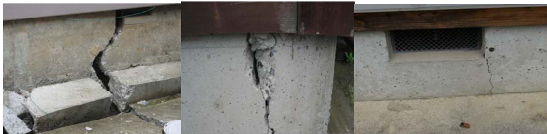
写真-10.6.5 ブロック基礎の被害例 (外周をモルタル等で覆って無筋コンクリートと区別が難しい場合もある)
