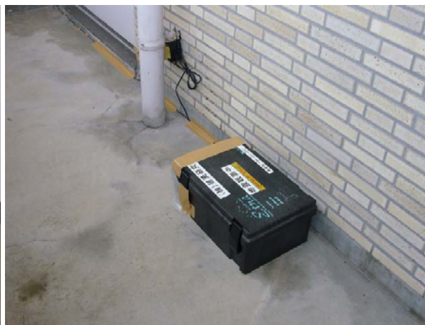
写真-10.3.8 門前支所3階強震計設置状況
