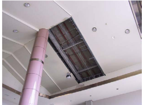
写真-10.5.14 エントランスホールの天井
