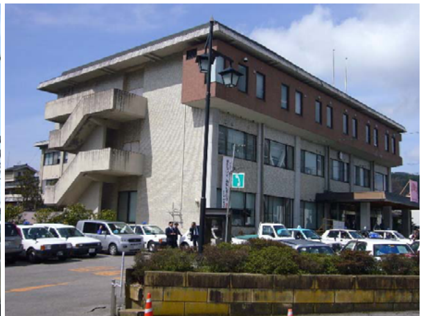
写真-10.3.6 門前支所概観(南東から)
