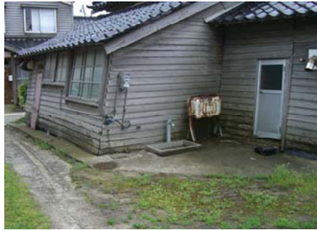
写真-10.6.4 土台から上部の建物被害 (土台から上部の建物の変形と外壁の破損)
