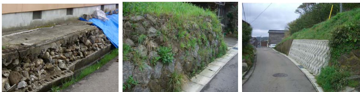
写真-10.6.10 道下地区の土留め・擁壁の状況
