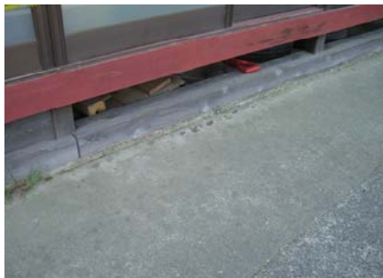
写真-10.6.1 地上での立ち上がり部分がほとんどない古い土台基礎 (地表面付近に切石などを設け、地表面から数 cm ほど上部に木質土台を置く基礎形式)
