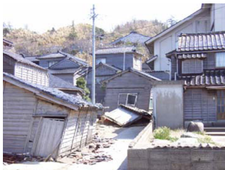
写真-10.4.13 黒島地区で倒壊・大破した納屋等
