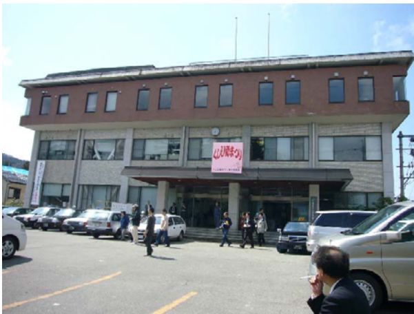
写真-10.3.5 門前支所概観(東から)
