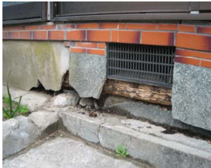
写真-10.6.5 ブロック基礎の被害例 (外周をモルタル等で覆って無筋コンクリートと区別が難しい場合もある)
