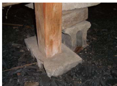
写真-10.6.3 土台基礎やブロック基礎を用いた住宅の建物内部の束基礎
