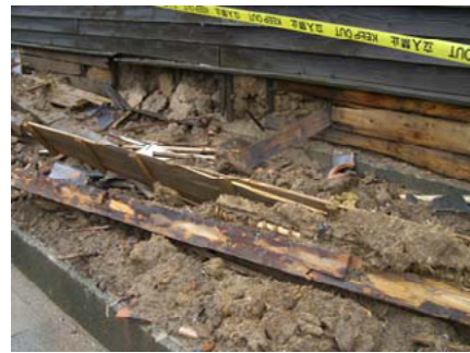
写真-10.6.4 土台から上部の建物被害 (土台から上部の建物の変形と外壁の破損)
