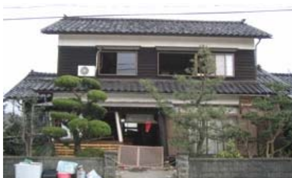
写真-10.4.5 旧蓮田に建ち、隣家より
