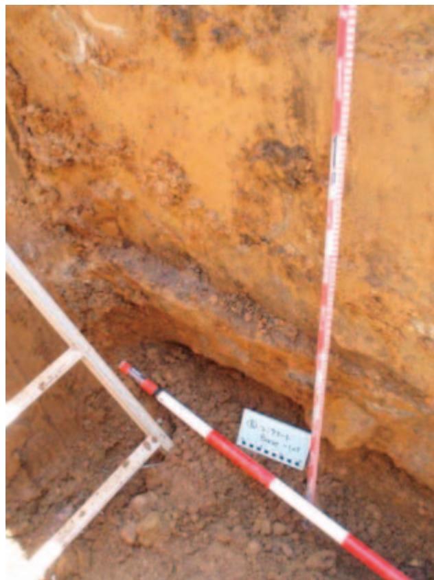
写真-6.15 トレンチ坑⑥のコンクリート壁の底部（下流側）（柏崎市提供）
