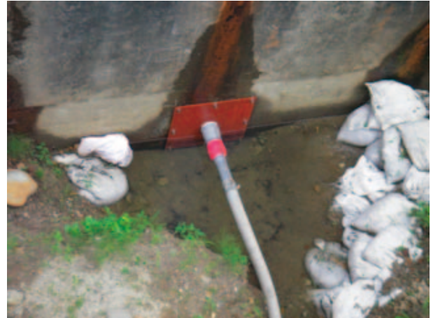
写真-6.21 導水管切断及び仮設管接続箇所
