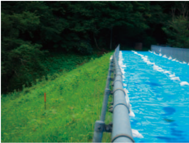
写真-6.7 地震後の天端欄干手すりの状況 （下流側への変形）（2007.7.17 撮影）
