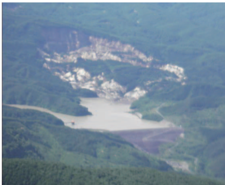
写真-5.18 荒砥沢ダムと貯水池周辺で発生した地すべり（6月15日14:24撮影）
