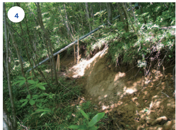
写真-3.4.40 滑落崖上部斜面に発生した 亀裂（7月15日撮影）
