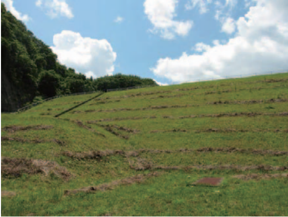
写真-5.53 衣川5号ダム堤体
