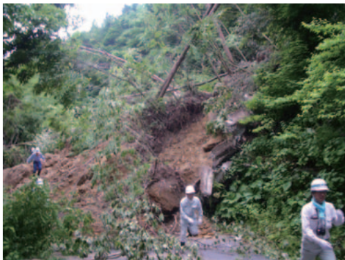
写真-3.4.51 最下流部の道路上に崩落した土砂の状況 (6月22日撮影)
