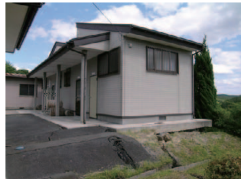
(b) 南側斜面擁壁上部の建物
