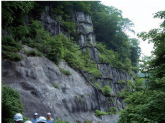
写真-3.4.49 のり砕工の状況のり砕工は健全であるが路面上に落石が散在している。(6月22日撮影)
