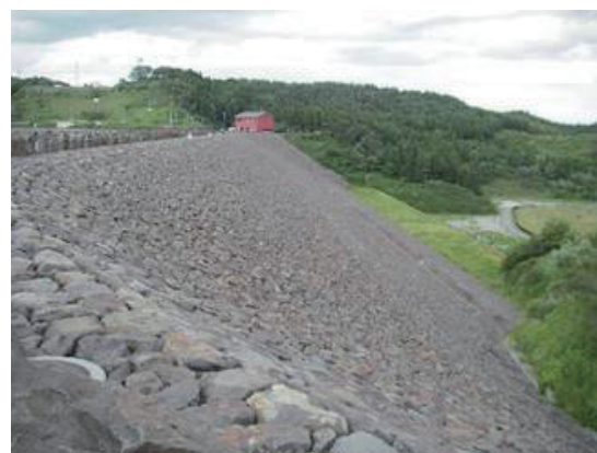
写真-5.34 堤体下流面の状況（リップラップにずれは認められない）
