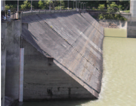
写真-5.1(a) 上流面表面遮水壁の状況(損傷は外見上認められない)
