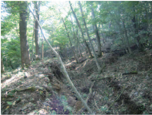
写真-2.2.24 地点 d に生じた変状
