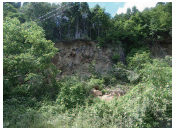
(b) 自然斜面の状況
