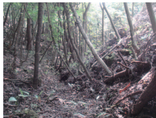
写真-2.2.27 地点 j（谷部）に生じた変状
