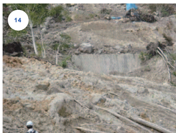
写真-3.4.28 市道のブロック積擁壁（変状なし）（8月9日撮影）
