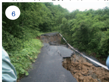
写真-3.4.18 比較的小規模な地すべりの状況（7月14日撮影）
