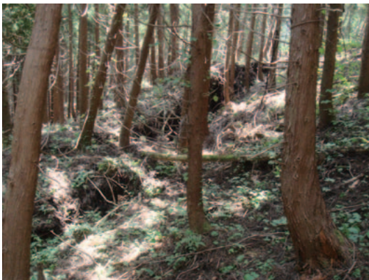
写真-2.2.26 地点 f に生じた変状
