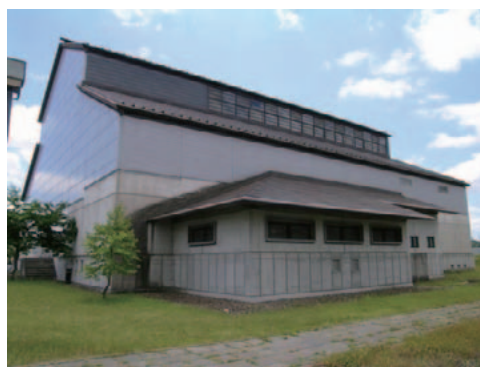
図-8.2.7 D建築物北面（高窓に被害なし）
