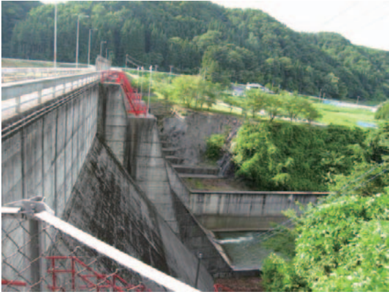
写真-5.46 衣川2号ダム堤体（重力式コンクリート堤体部）
