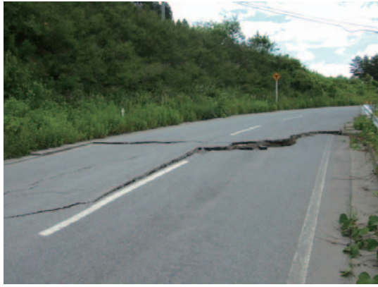
図-7.4.3 国道397号取付け道路の高盛土に生じたクラックとのり面の状況
