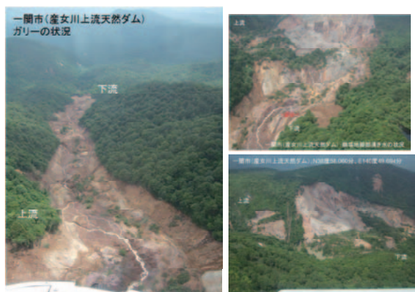
図-3.3.3 6月20日みちのく号による調査写真。産女川の崩壊地
