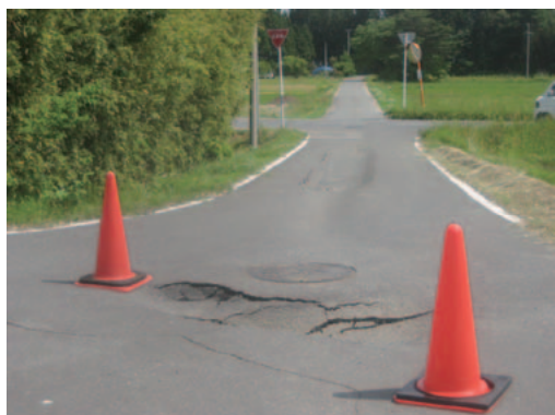
写真-4.5 埋戻し部沈下【栗原市・一迫北郷】
