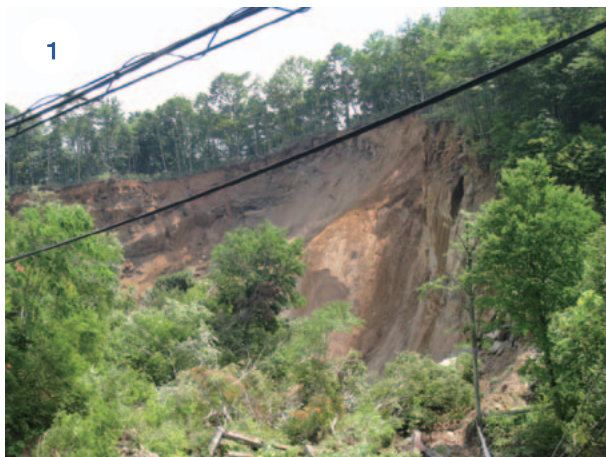
写真-3.4.41 頭部滑落崖 (高さ30~50m) (7月15日撮影)
