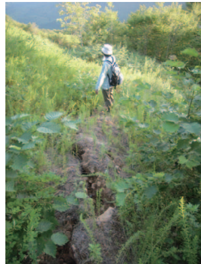
写真-2.2.6 地点gの変状
