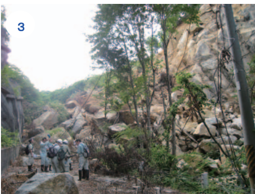
写真-3.4.47 地すべり末端部の状況（下流より）（7月15日撮影）
