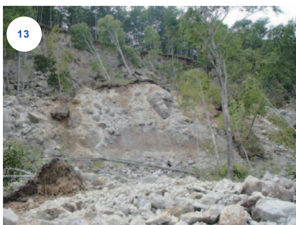
写真-3.4.27 A-A断面付近の頭部滑落崖（円弧すべり）（8月9日撮影）
