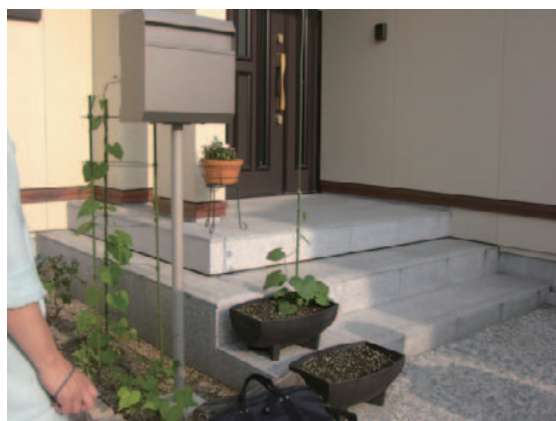
(a) 玄関付近（変状なし）
