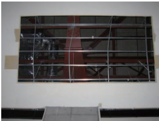
図-8.4.18 天井板脱落箇所及び下地材損傷状況
