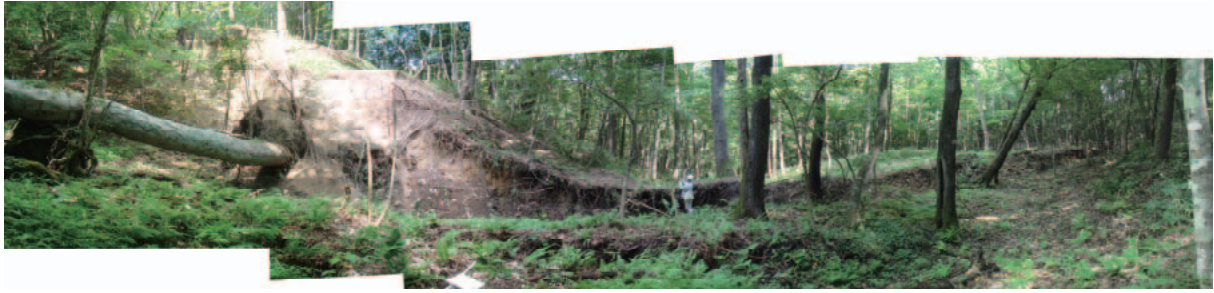
写真-2.2.23 地点 c に生じた変状
