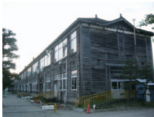
図-8.2.22 J小学校旧校舎（北校舎）の外観（無被害）
