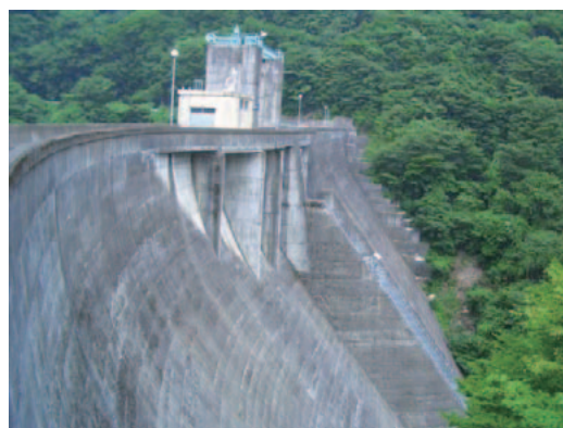
写真-5.36 栗駒ダム堤体
