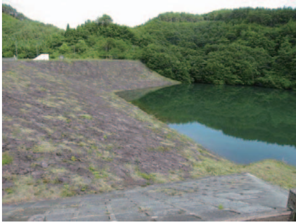
写真-5.50 衣川4号ダム上流面
