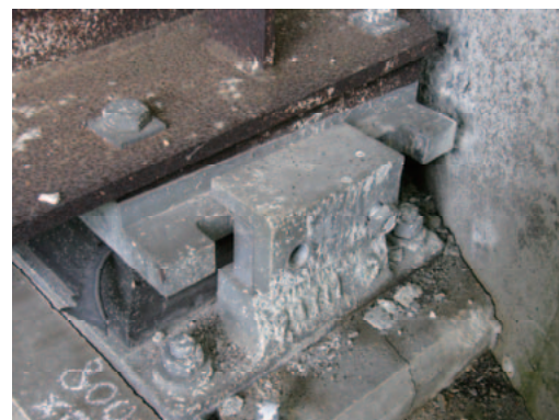
写真-6.40 A1 橋台支承部の損傷
