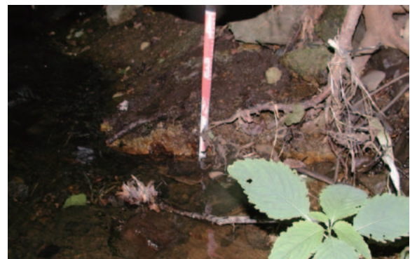
写真-2.2.20 地点 g の基盤岩の断層面
