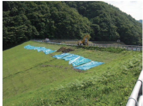
写真-5.41 衣川1号ダム堤体
