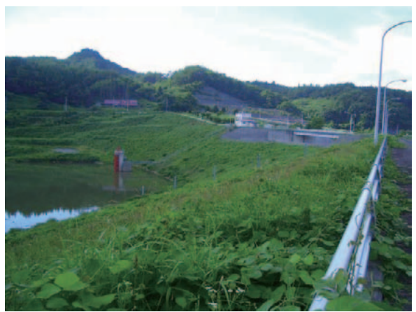
写真-5.49 衣川3号ダム堤体
