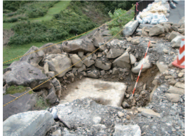
写真-5.7 天端開削調査で確認 した埋設ピア頂部（東北地方 整備局北上川ダム統合管理 事務所提供）
