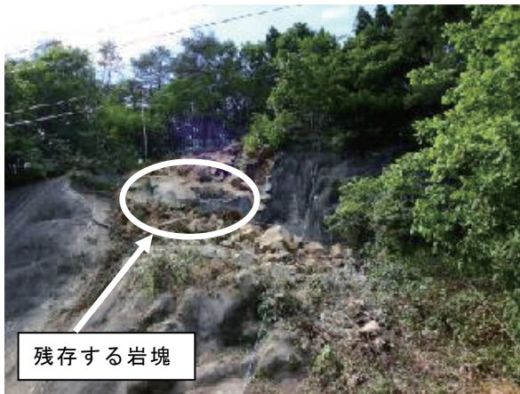
(a) 吹付のり面の状況
