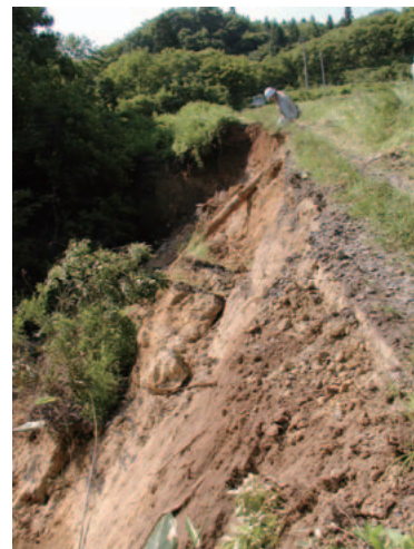
写真-2.2.13 地点gの斜面崩壊
