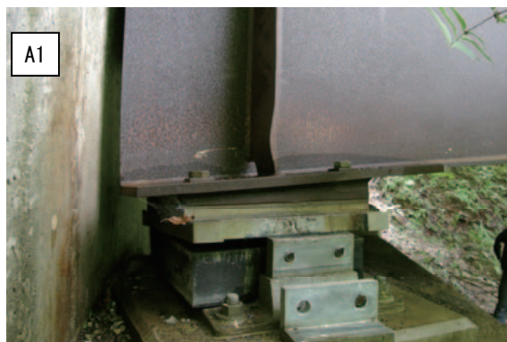
写真-6.40 A1 橋台支承部の損傷
