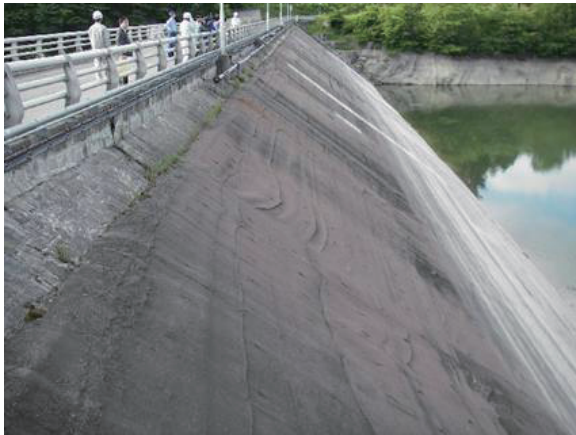
写真-5.25 堤体上流遮水壁の状況（地震による変状は認められない）
