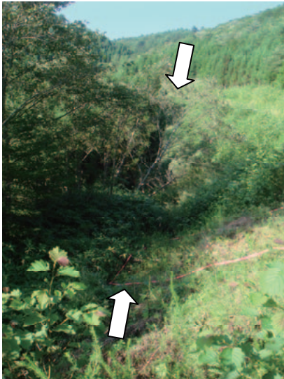
写真-2.2.3 地点cの変状
