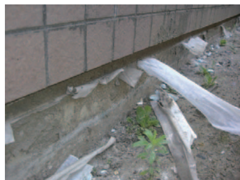
図-8.5.4 フィルム状シートのはみ出し
