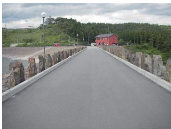
写真-5.33 天端の状況（舗装面に亀裂は認められない）
