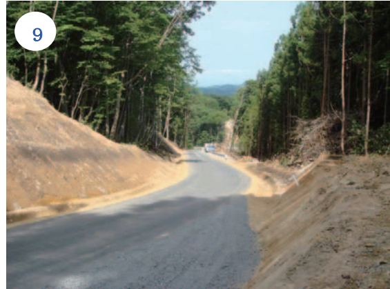
写真-3.4.21 完成後の仮設道路の状況（8月9日撮影）
