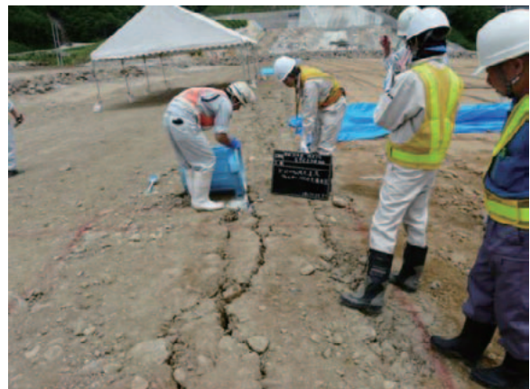
写真-5.11 亀裂深度調査状況 (フィルタ 一部) (東北地方整備局胆沢 ダム工事事務所提供)
