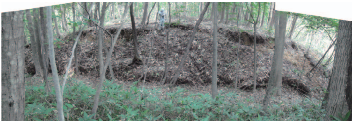
写真-2.2.22 地点 b に生じた変状
