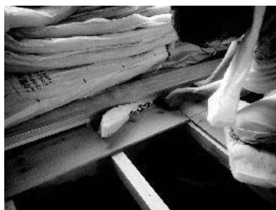
図7 床下への吹付け施工の様子
