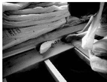
図 16 ●荒板と敷居の間に気流止めを充填
