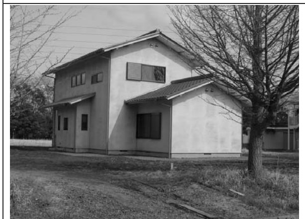
図5 外観写真(北・西面)
