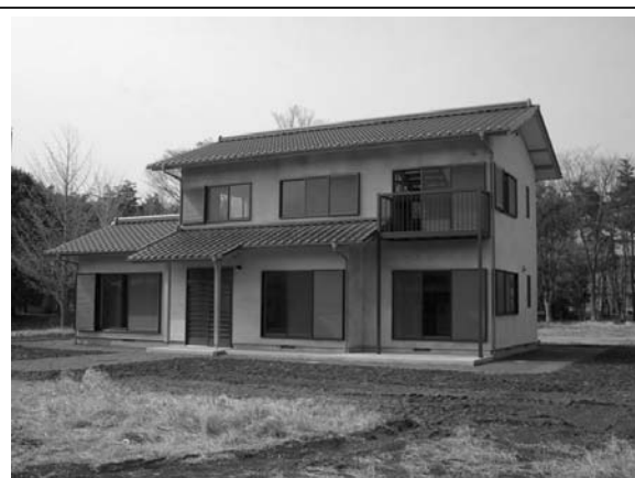
図4 外観写真(南・東面)
