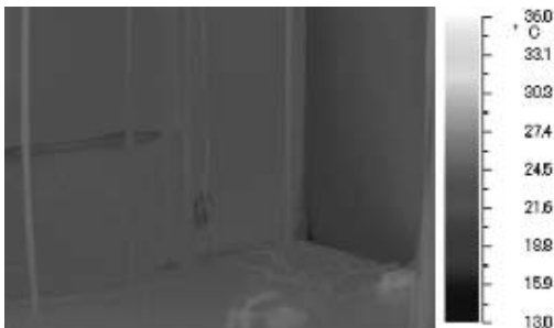
図 24 改修前(和室西戸境壁入り隅)(改修前:室内 24.5^{\circ}\text{C} 、外気 1.5^{\circ}\text{C} )
