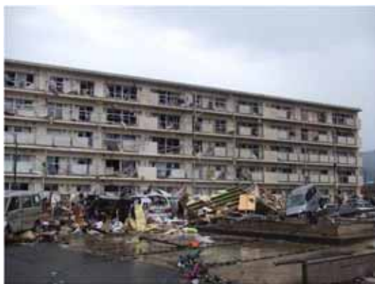
写真 4.1-1 つくば竜巻(2012)での飛散物の状況
