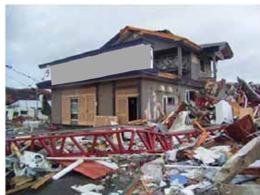
写真 4.1-2 佐呂間竜巻(2006)での飛散物の状況
