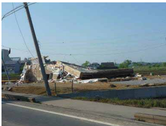
写真 4.2-1 上部構造の転倒
