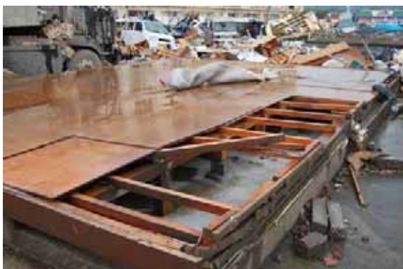
写真 4.2-3 上部構造の飛散
