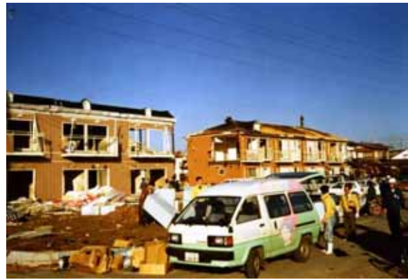
写真 6.2-8 茂原竜巻（1990）での軽量鉄骨造集合 住宅の被害（茂原市消防署）
