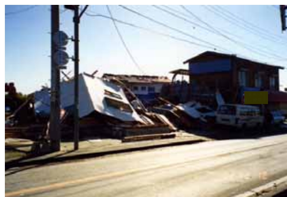
写真 6.2-4 茂原竜巻（1990）での作業 所の倒壊（茂原市消防署）
