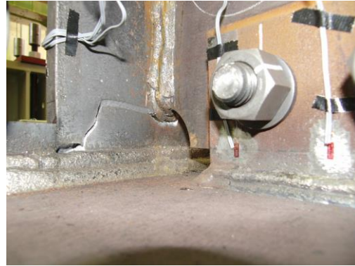
上フランジ破断状況(+67 サイクル)
