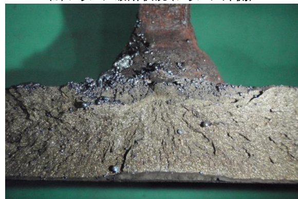
(d) スカラップ底のき裂の起点部
