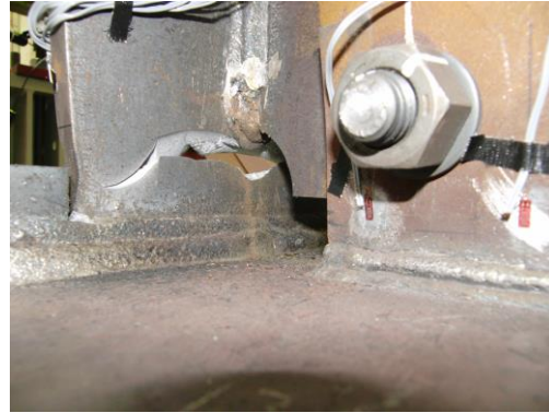
上フランジ破断状況(+5 サイクル)
