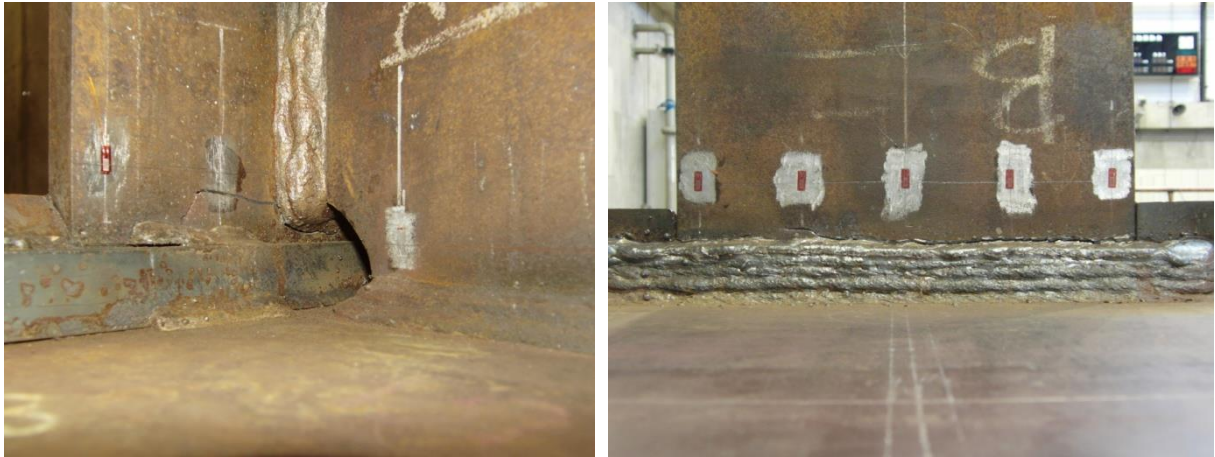
写真 2.3.2-2 最終破壊状況(K-09:-382 サイクル)
