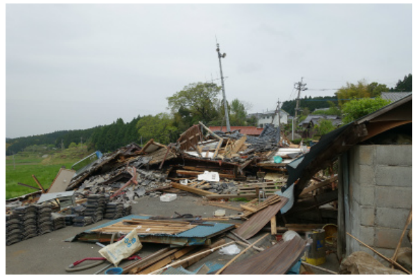
写真 5.3-37 倒壊した木造住宅
