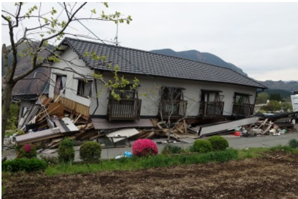
写真 5.3-58 倒壊した木造アパート
