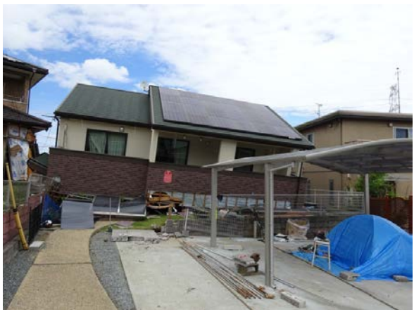
写真 5.3-18 倒壊した木造住宅
