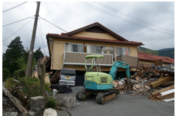
写真 5.3-65 倒壊した木造住宅
