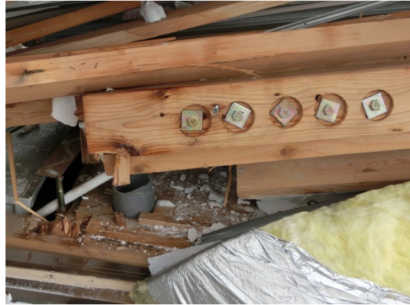
写真5.3-21 写真5.3.20の建物の写真筋かい端部、柱脚接合部（金物を確認）
