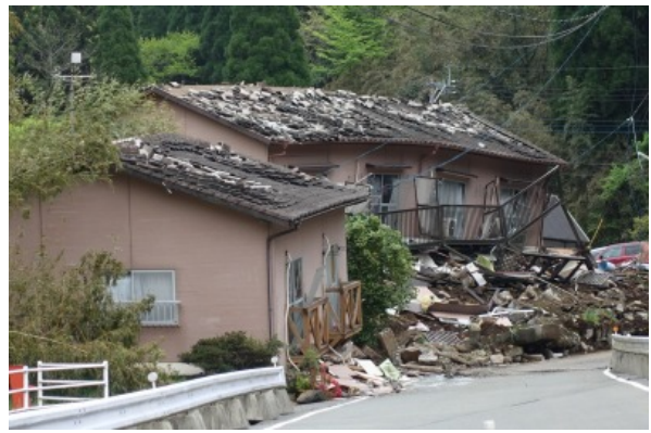
写真 5.3-63 倒壊した木造アパート
