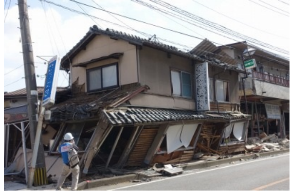
写真 5.3-7 大きく傾斜した店舗併用住宅
