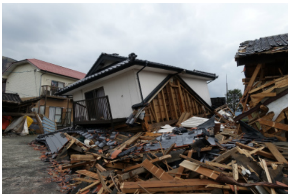
写真 5.3-66 倒壊した木造住宅
