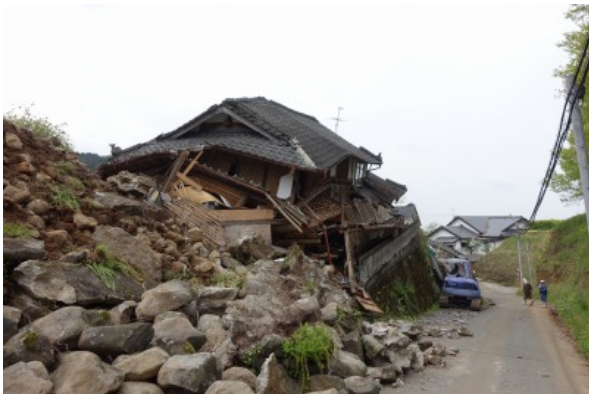
写真 5.3-40 倒壊した木造住宅
