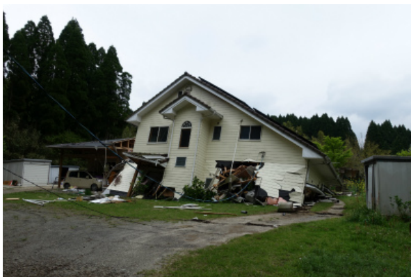
写真 5.3-68 倒壊した木造住宅（金物あり）
