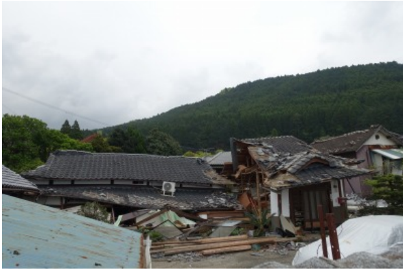
写真 5.3-28 分離した木造住宅
