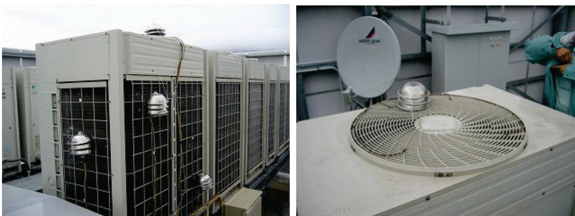
図IV. 2. 2. 7 室外機計測の様子
