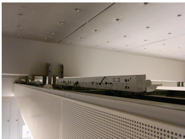
図 V. 2. 2. 42 ダクト裏 間接照明設置状況
