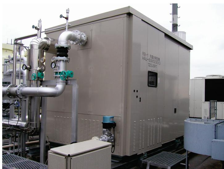
図Ⅲ.4.4.3.2. 事務所 1C 熱源機設置状況
