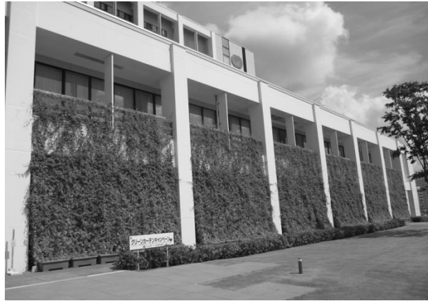
写真 2 市役所庁舎に設置された緑のカーテン（茨城県つくば市庁舎）
