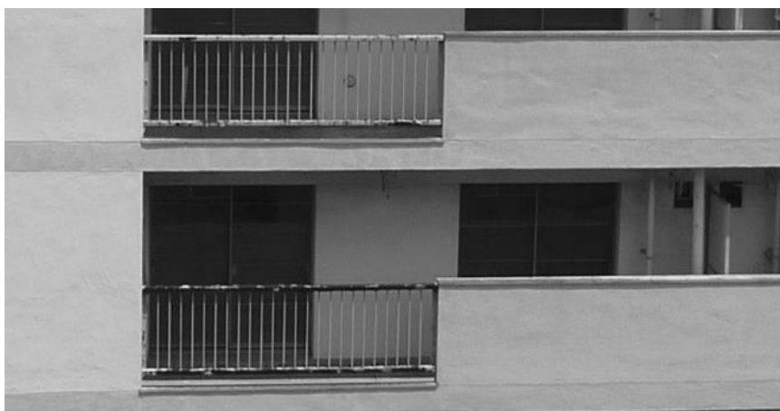
写真1-2 ベランダに面した壁面
