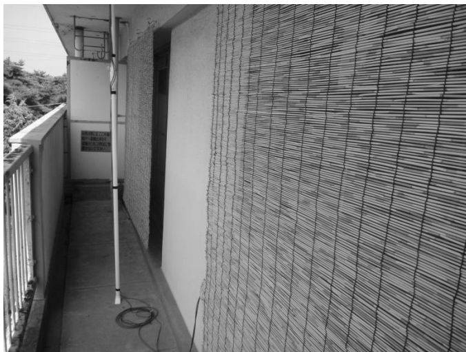
写真 1-6 407 号室 スダレを設置
