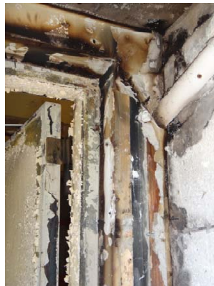
写真 4.7.7-25 1 階防火壁防火戸枠部分詳細
