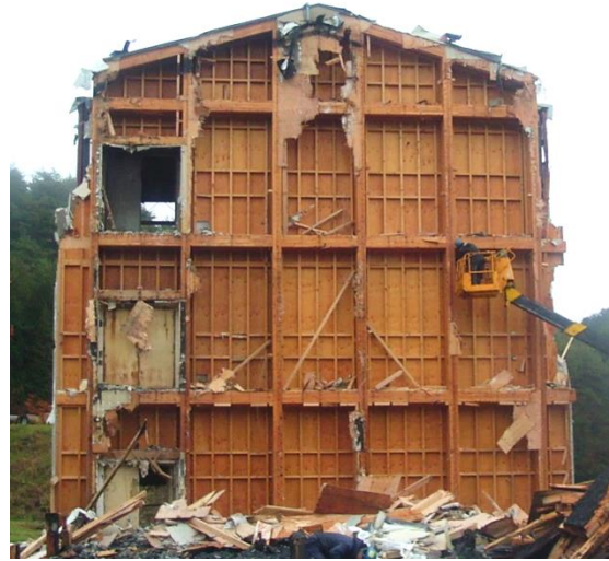
図 4.7.7-30 合板撤去後の防火壁の状況
