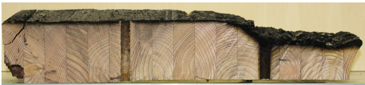
写真 4.7.7-36 ドリフトピン周りの炭化状況
