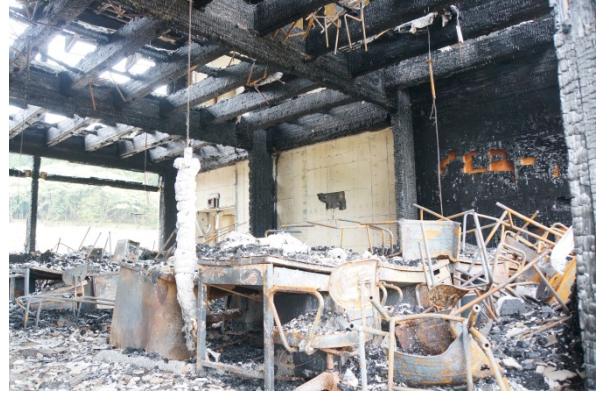
写真 4.7.7-11 1階防火壁側耐力壁の様子
