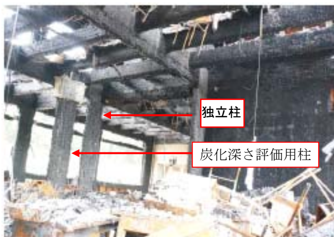
写真 4.7.3-1 消火後の独立柱および炭化深さ評価用柱の状態
