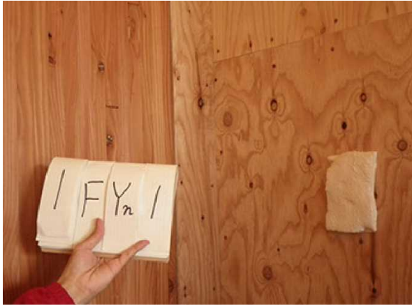
写真 4.5.3-3 壁表面熱電対設置の様子
