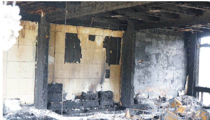
写真 4.7.7-17 2階防火壁側耐力壁の様子
