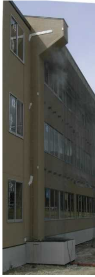
写真 4.5.8-2 微差圧計の配管
