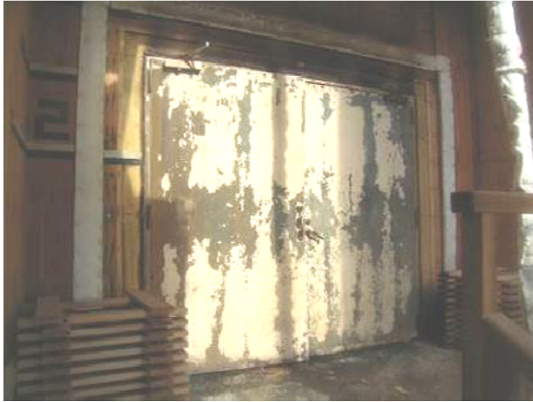
写真 4.7.7-26 2階階段室側防火戸の状況
