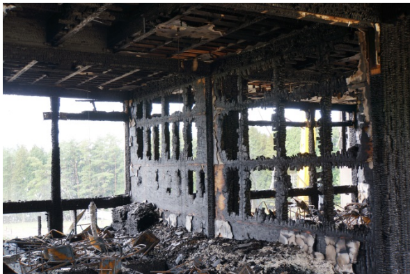
写真 4.7.7-18 2階中央間仕切り壁の様子
