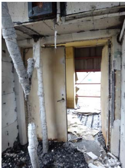
写真 4.7.7-24 1 階防火壁防火戸の状況
