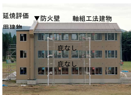
写真 4.2.8-2 本実験における実験建物(北面)
