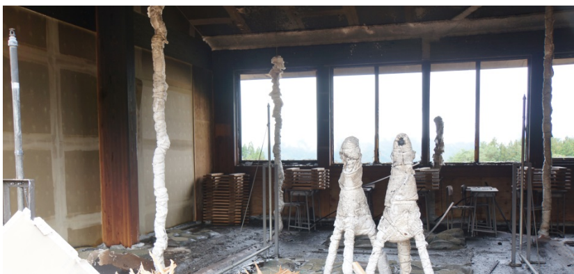
写真 4.7.7-20 3階B・Cブロック教室の様子
