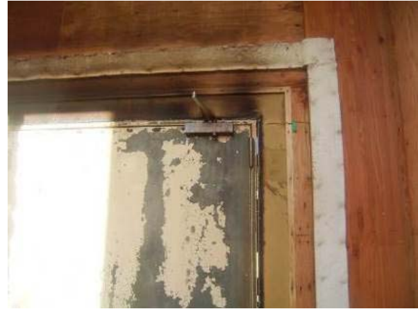
写真 4.7.7-27 2階階段室防火戸枠部分詳細
