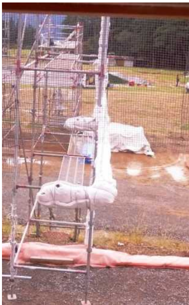
a) 熱流束計の設置状況
