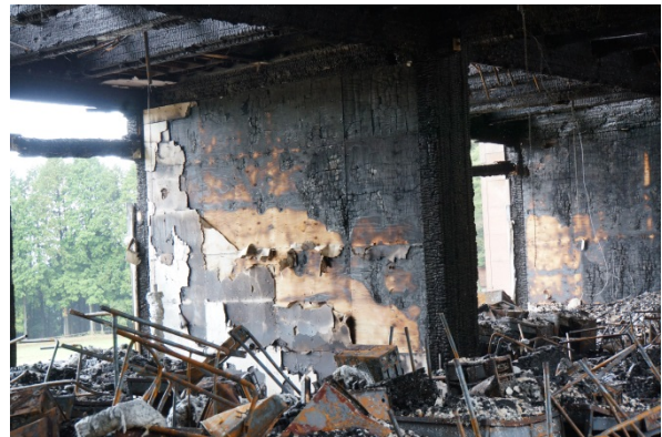
写真 4.7.7-13 1階Dブロック側耐力壁の様子
