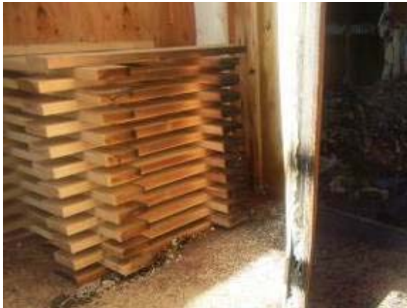
写真 4.7.7-28 防火戸近傍のクリブの変色
