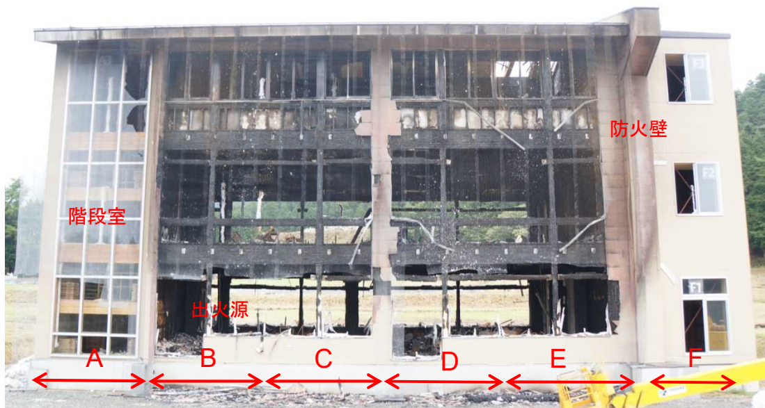
写真 4.7.7-6 実験後の実験建物（南面）
