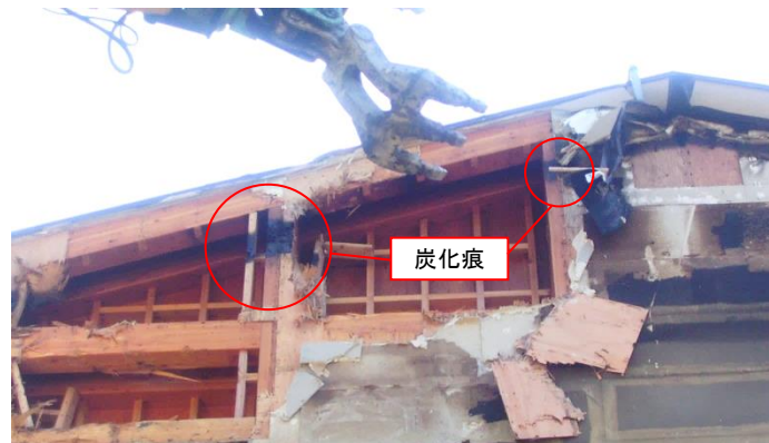
写真 4.7.7-31 防火壁の残火による炭化痕
