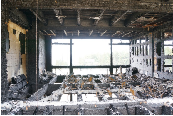
写真 4.7.7-14 2階D・Eブロック教室の様子
