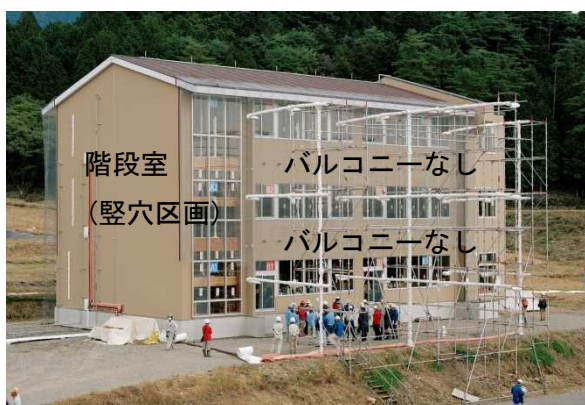
写真 4.2.8-1 本実験における実験建物(南面)
