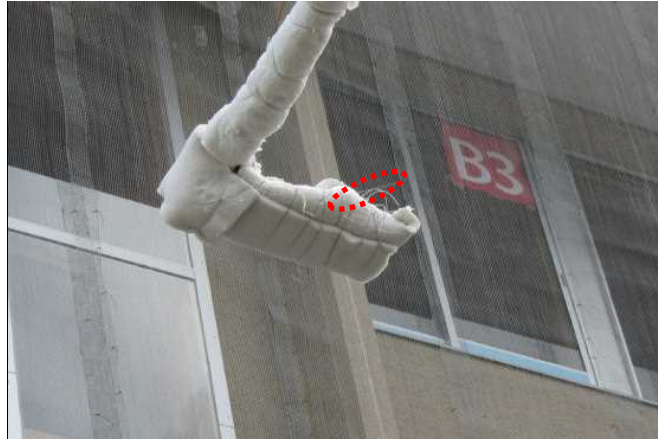
写真 4.5.4-4 熱流束計および屋外雰囲気温度測定用シース熱電対の設置状況
