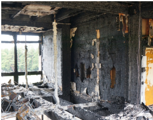
写真 4.7.7-16 2階階段室側耐力壁の様子
