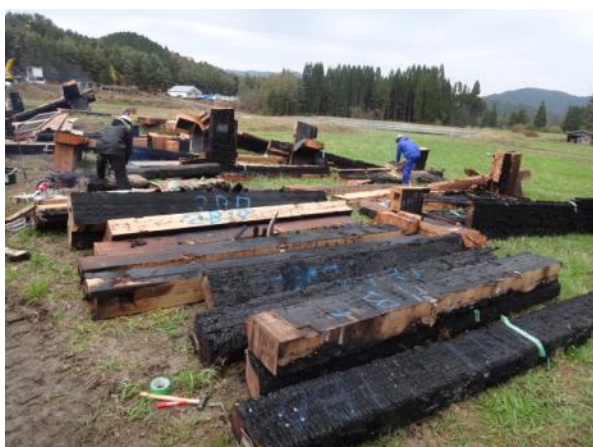
写真 4.7.7-3 解体部材のナンバリング
