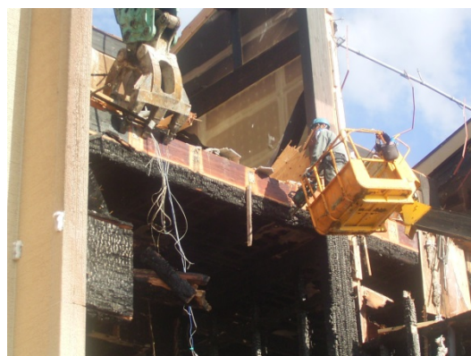
写真 4.7.7-2 構造部材解体・採取の様子
