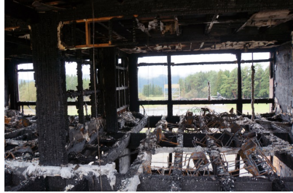
写真 4.7.7-15 2階 B・C ブロック教室の様子
