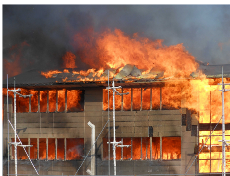
写真 2.7.7-6 屋根の燃え抜け
