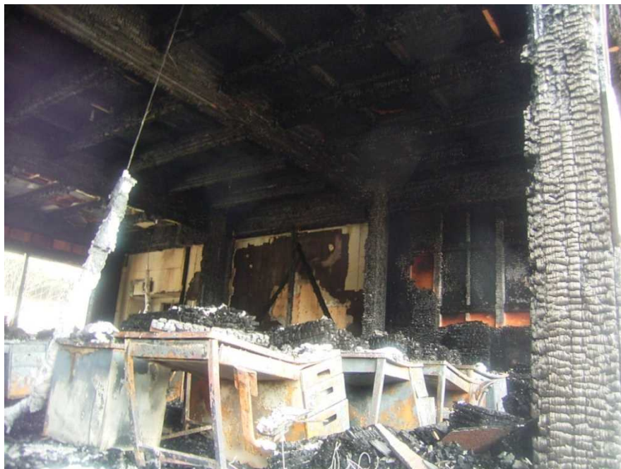
写真 3.7.7-9 1階 D・Eブロック（職員室南側）内部の状況
