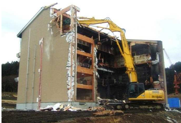
写真 3.7.7-1 建物南側上階からの解体の様子
