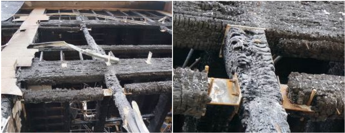
写真 4.7.7-31 1階開口部軸組の接合部
