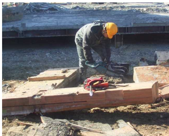
写真 3.7.7-4 解体部材からの断面サンプル採取
