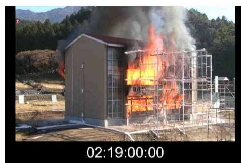
写真 3.7.2-20 3階延焼時(南側)
