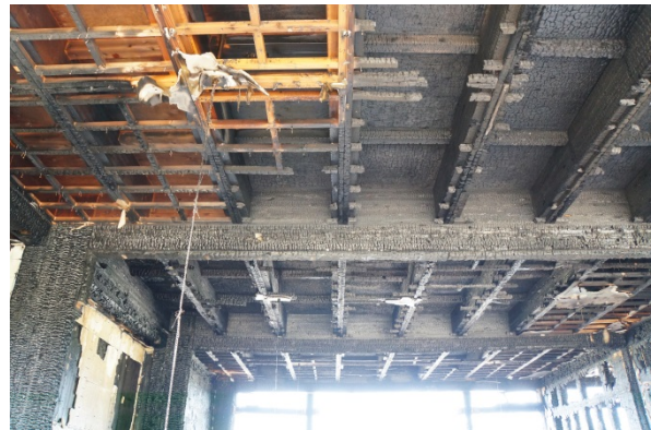
写真 4.7.7-19 2階 D・E ブロック天井の様子
