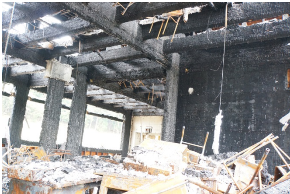
写真 4.7.7-12 1階Cブロック側耐力壁の様子
