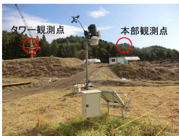
写真 3.5.1-1 気象観測装置（実験建物観測点）
