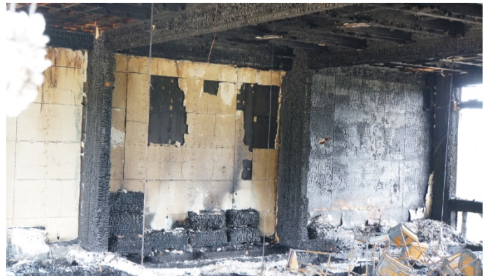
写真 4.7.7-17 2階防火壁側耐力壁の様子
