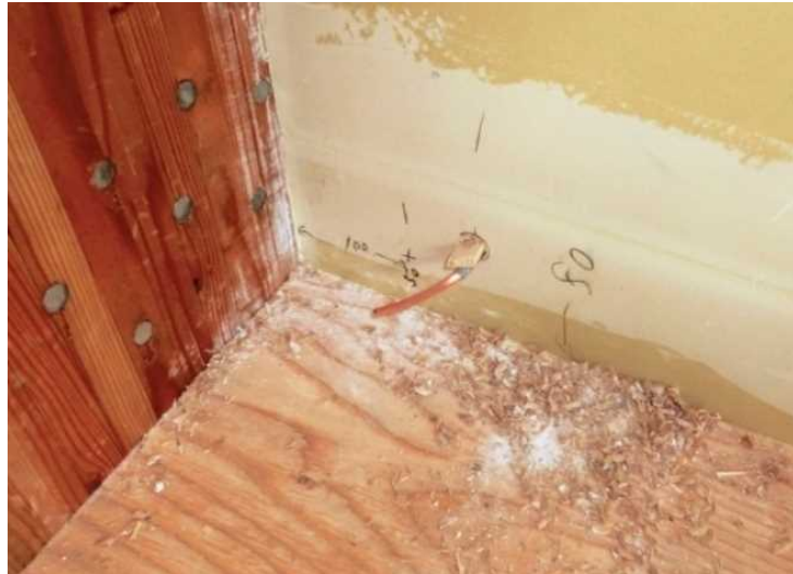
写真 3.5.8-1 微差圧計のチューブの端部（施工中に撮影）
