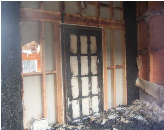
写真 3.7.7-22 1階階段室防火戸の残存状況
