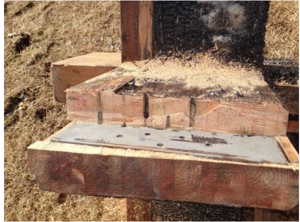
写真 3.7.7-32 2階接合部の状況例
