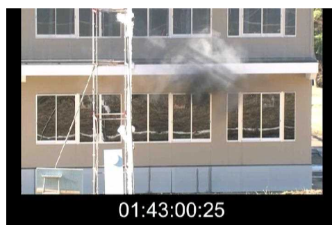
写真 3.7.2-9 北側窓ガラスの破損
