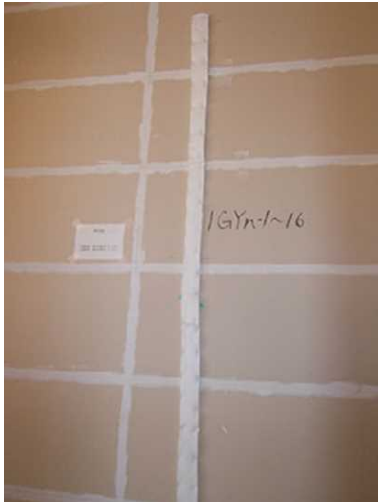
写真 2.5.3-3 壁表面熱電対様子
