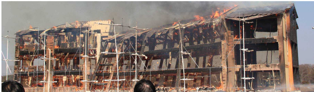
写真 2.7.7-4 軸組構法①部分倒壊の様子 (76 分)
