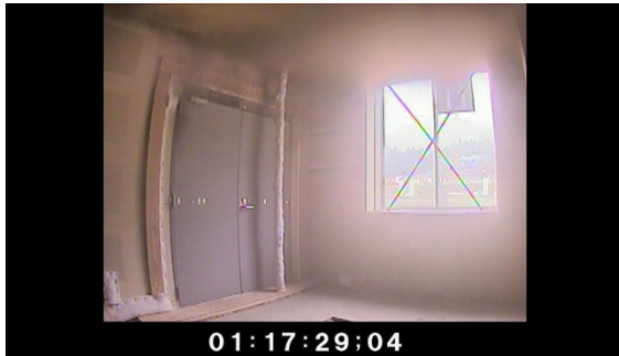
写真 4.7.2-24 防火戸から侵入する煙
