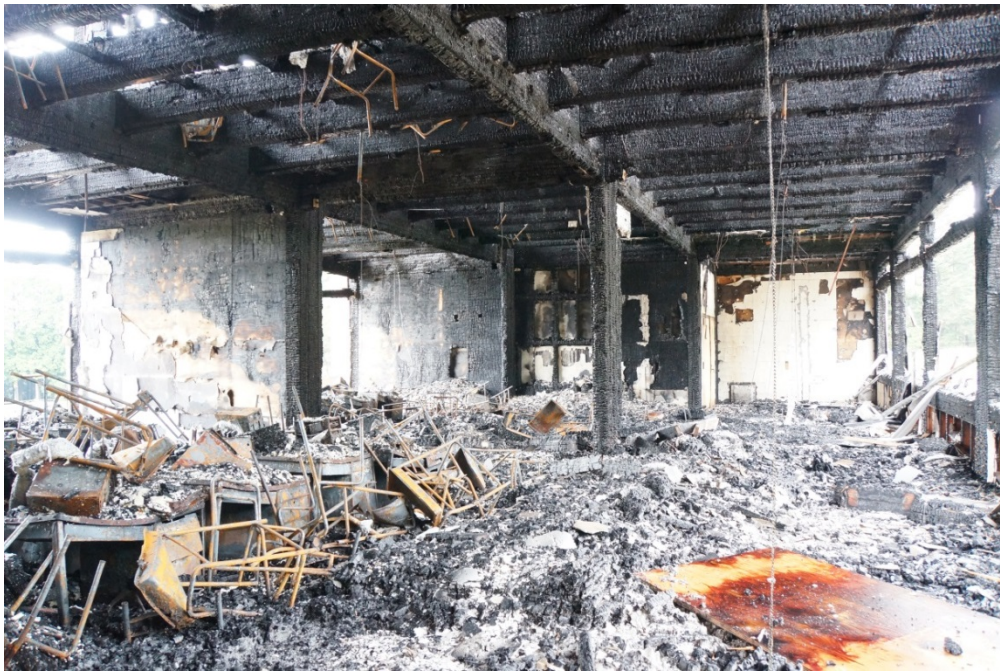
写真 4.7.7-9 1階の状況（北側廊下防火壁側より）
