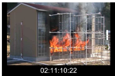
写真 3.7.2-15 2階からの火炎の噴出
