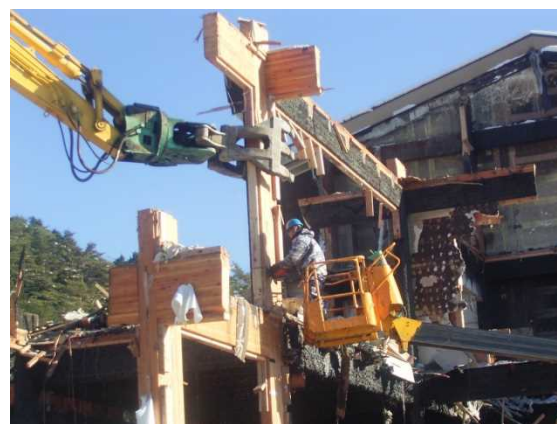
写真 3.7.7-2 構造部材解体・採取の様子
