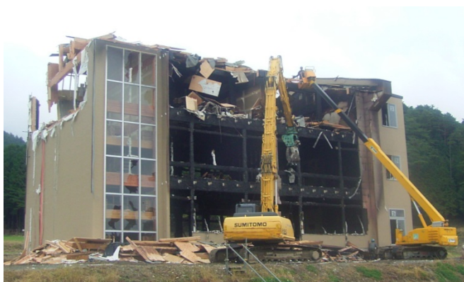
写真 4.7.7-1 建物上階からの解体の様子
