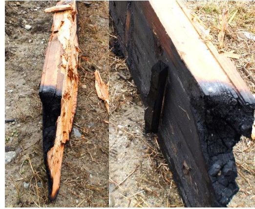
写真 4.7.7-23 北側桁の残火による燃焼跡
