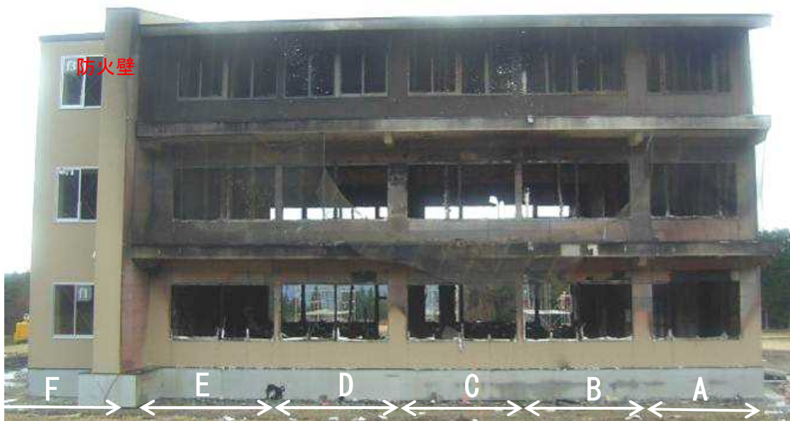
写真 3.7.7-7 実験後の実験建物（北面）
