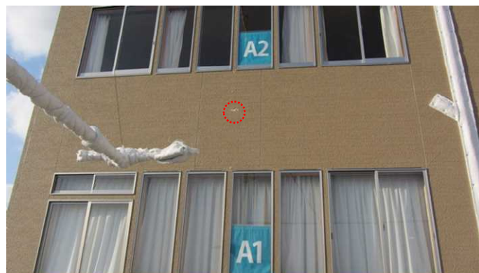
b) 外壁面の熱流束計設置状況
