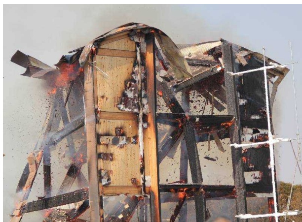
写真 2.7.7-5 軸組構法②部分倒壊の様子 (123 分)
