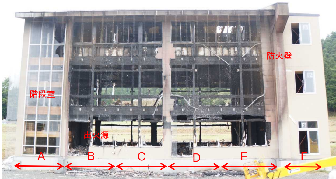
写真 4.7.7-6 実験後の実験建物（南面）
