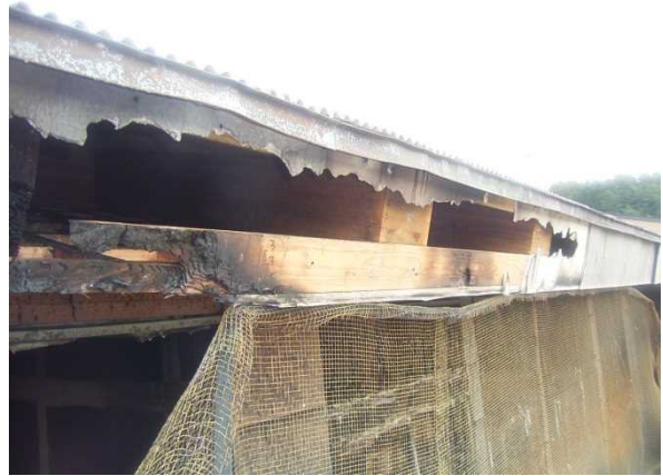
写真 3.7.7-21a 南側軒先の損傷と垂木の燃焼状況 写真 3.7.7-21b 南側軒先の損傷の様子
