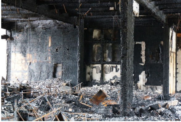
写真 4.7.7-10 1階階段室側耐力壁の様子
