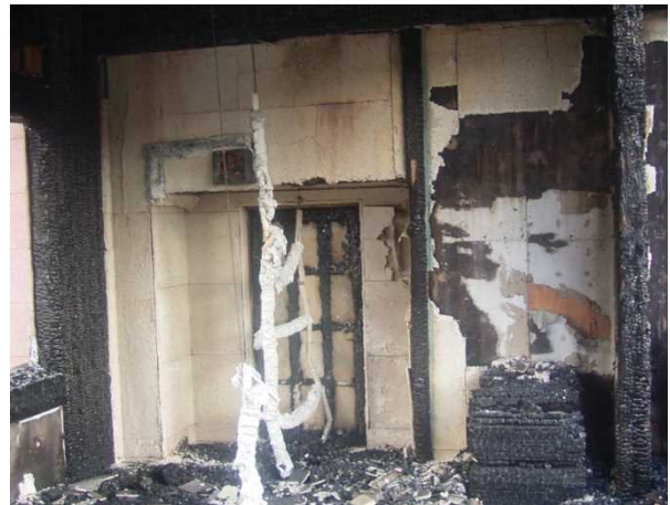
写真 3.7.7-23 1階防火壁防火戸の残存状況
