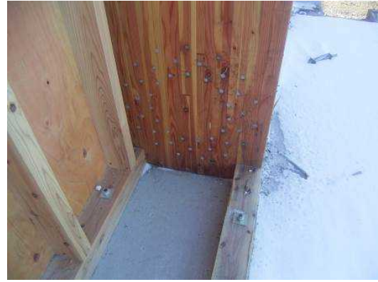
写真 3.7.7-28 柱脚接合部の状況
