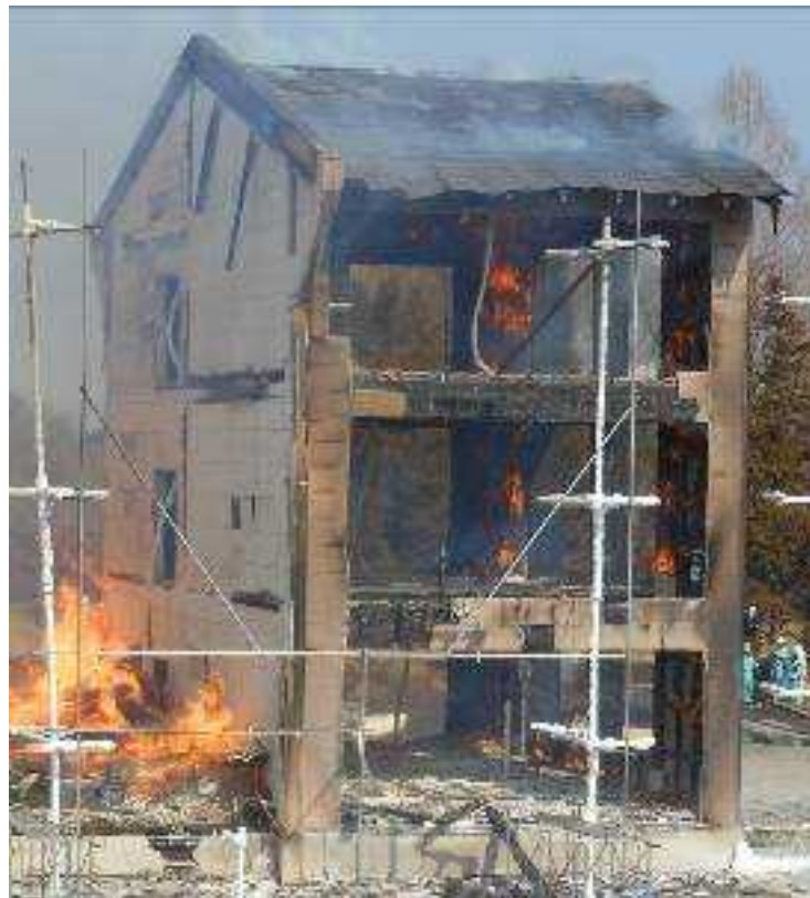
写真 2.7.7-15 倒壊前の防火壁
