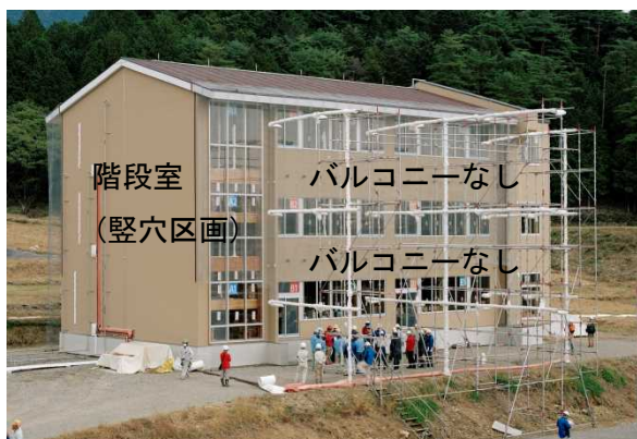
写真 4.2.8-1 本実験における実験建物(南面)
