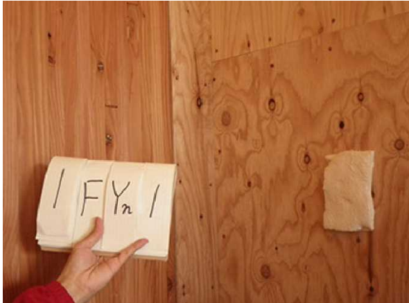
写真 4.5.3-3 壁表面熱電対設置の様子
