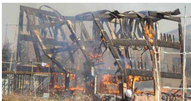
写真 2.7.7-8 枠組壁工法部分ラーメン架構の倒壊
