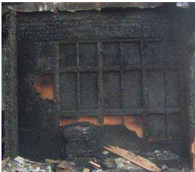
写真 3.7.7-12 1階防火壁側耐力壁の様子
