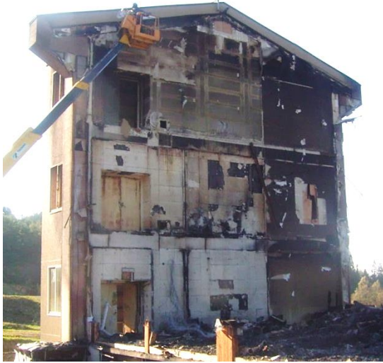
図 4.7.7-29 解体時の防火壁の状況
