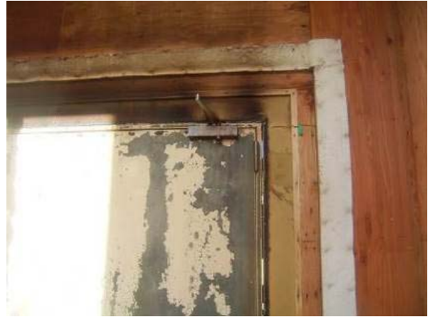
写真 4.7.7-27 2階階段室防火戸枠部分詳細
