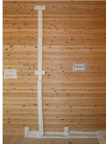
写真 2.5.3-4 熱電対配線様子
