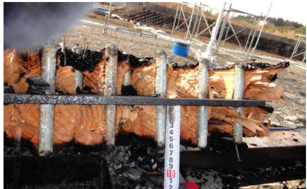
写真 2.7.7-11 残存した断面の測定
