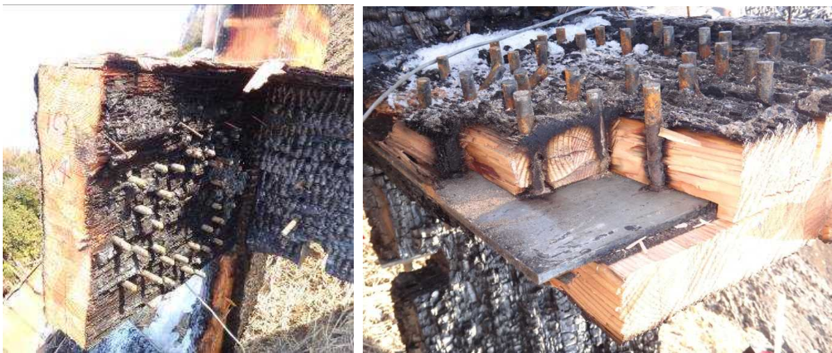
写真 3.7.7-31 1 階接合部の状況例
