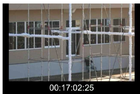
写真 3.7.2-3 掃き出し窓の解放
