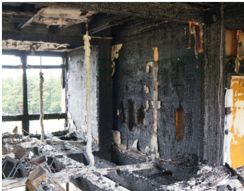
写真 4.7.7-16 2階階段室側耐力壁の様子
