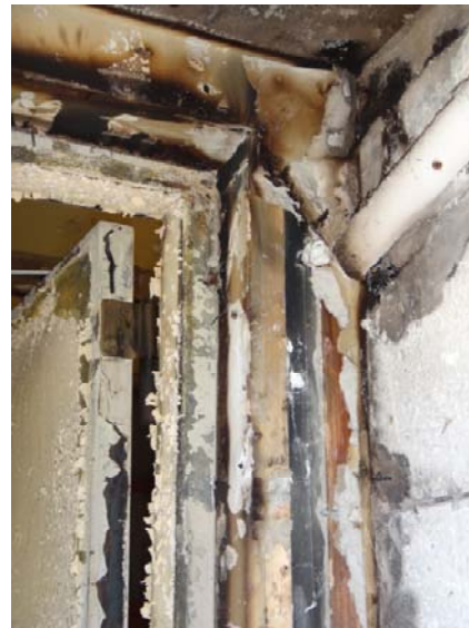
写真 4.7.7-25 1 階防火壁防火戸枠部分詳細
