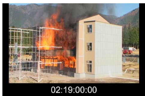
写真 3.7.2-19 3階延焼時(北側)
