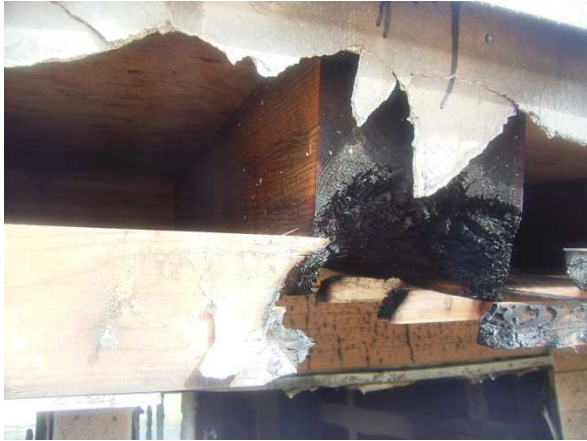
写真 3.7.7-21a 南側軒先の損傷と垂木の燃焼状況 写真 3.7.7-21b 南側軒先の損傷の様子
