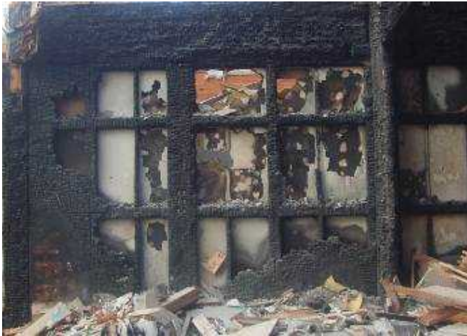
写真 3.7.7-10 1階階段室側耐力壁の様子
