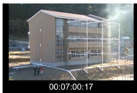
写真 3.7.2-2 窓からの煙の漏出
