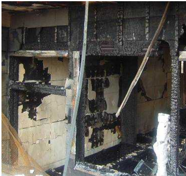
写真 3.7.7-16 2階階段室側耐力壁の様子
