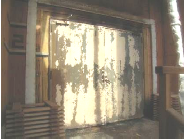
写真 4.7.7-26 2階階段室側防火戸の状況
