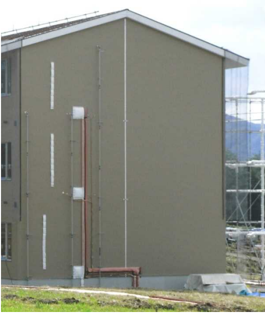
写真 4.5.8-2 微差圧計の配管
