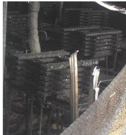
写真 3.7.7-19 2階クリブの燃え残り
