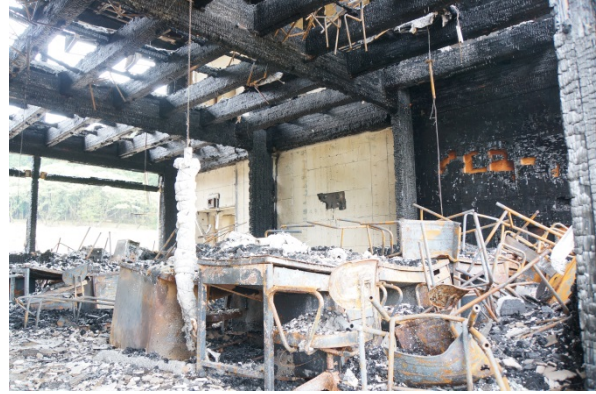
写真 4.7.7-11 1階防火壁側耐力壁の様子
