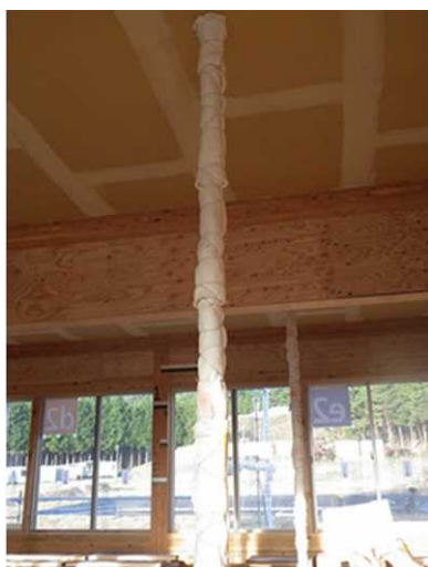
写真 4.5.3-1 熱電対タワー
