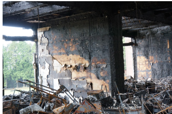
写真 4.7.7-13 1階Dブロック側耐力壁の様子
