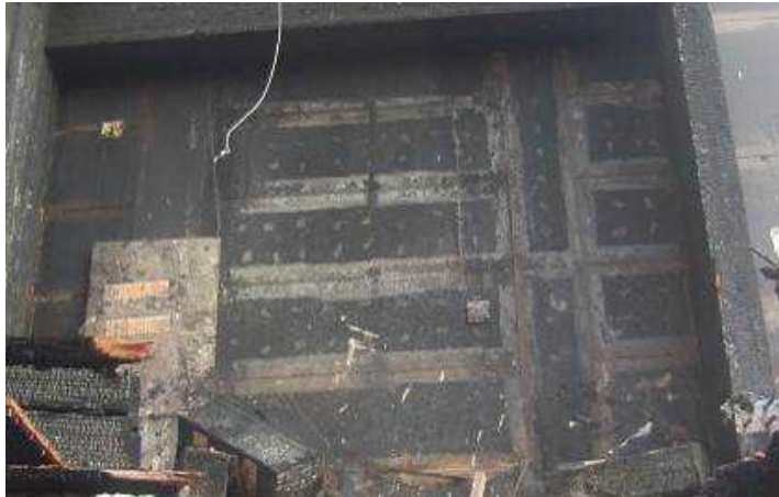
写真 3.7.7-18 2階防火壁側耐力壁の様子
