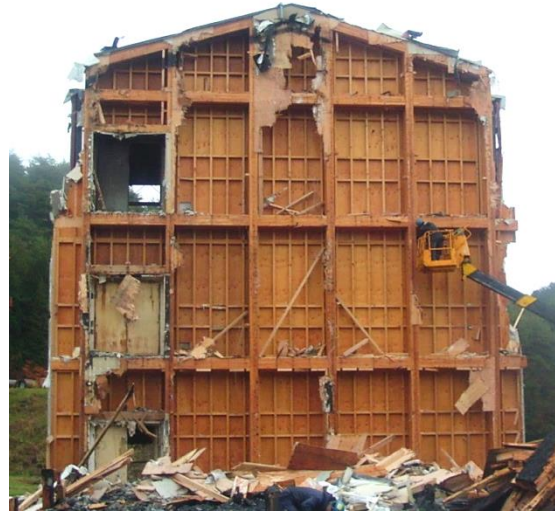
図 4.7.7-30 合板撤去後の防火壁の状況
