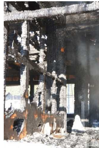
写真 3.7.7-11 1階中央耐力壁の様子
