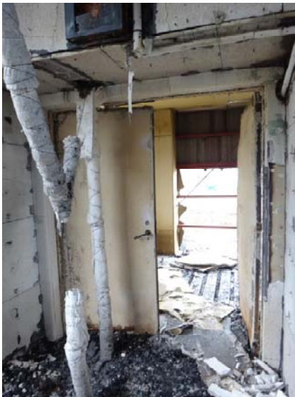
写真 4.7.7-24 1 階防火壁防火戸の状況
