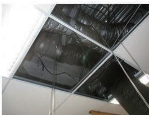
写真 18 RA 吸込み口に補助ダクトとフレキシブルダクトを追加
