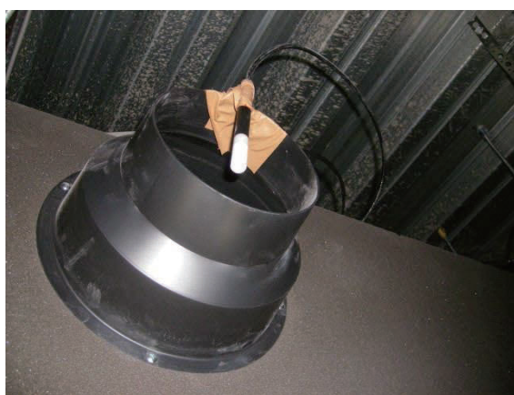
写真 3 外調機吸込み口センサー設置箇所
