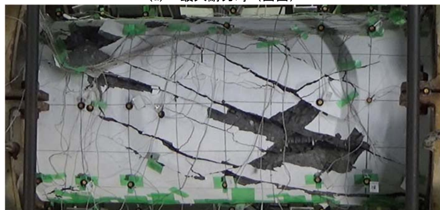
(c) 最終破壊状況 (西面)
