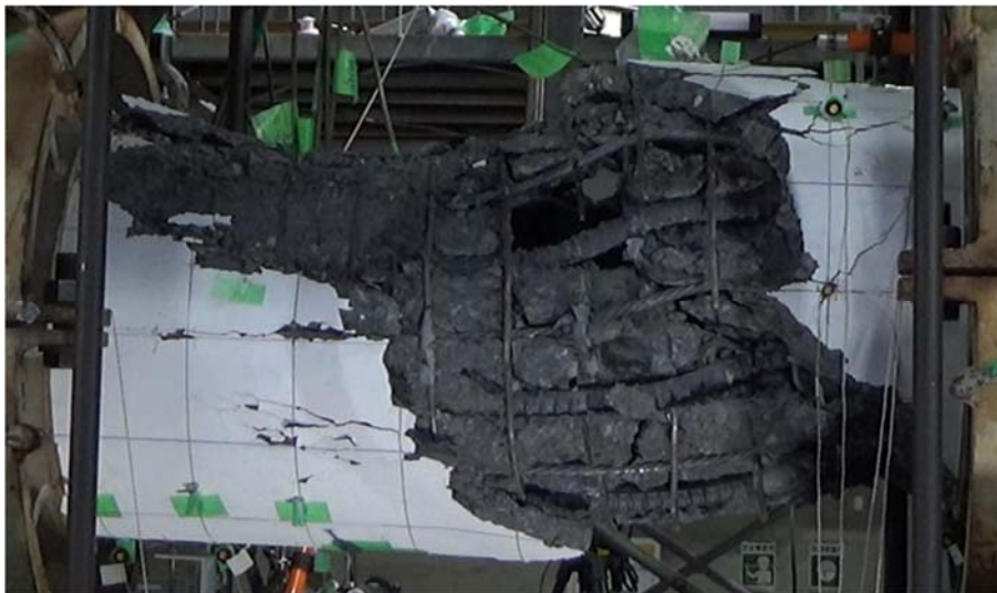
(e) 最終破壊状況（西面）
