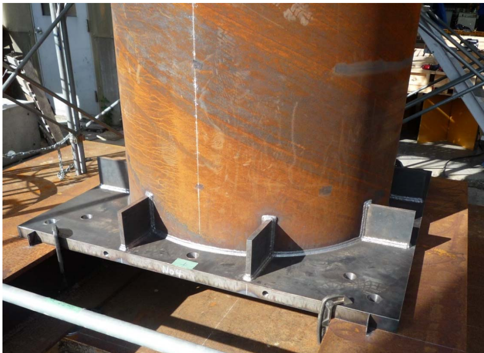
写真 6.3.3 端盤と鋼管の溶接状況
