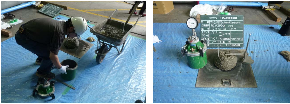
写真 6.3.6 コンクリート試験
