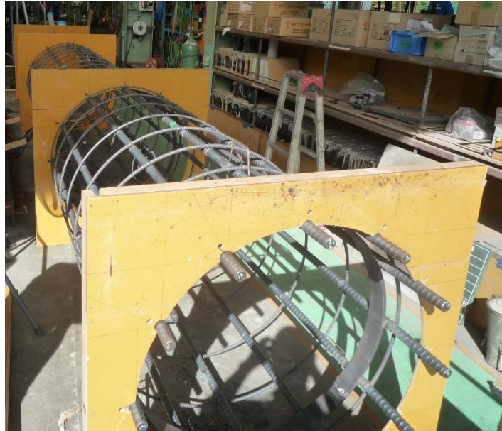
写真 6.3.2 鉄筋籠組立状況
