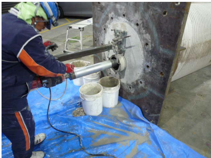
写真 6.4.5 コンクリート コア抜き状況
