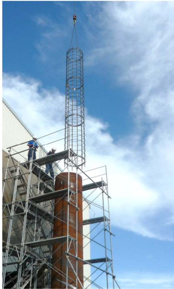
写真 6.3.4 鉄筋籠建込み
