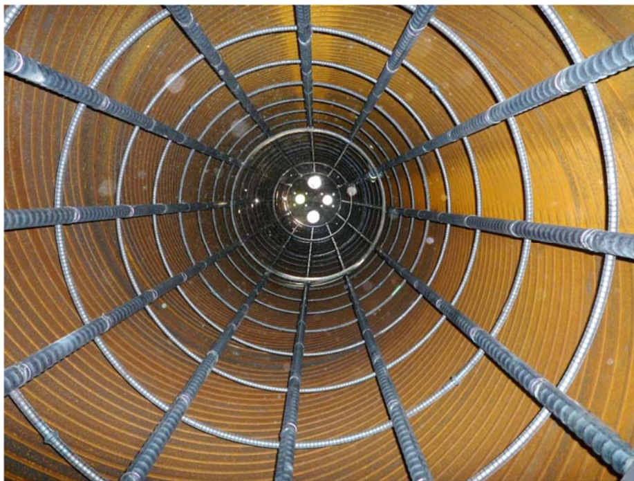
写真 6.3.5 鋼管内配筋状況 (SRC-TB1, SRC-TB2)
