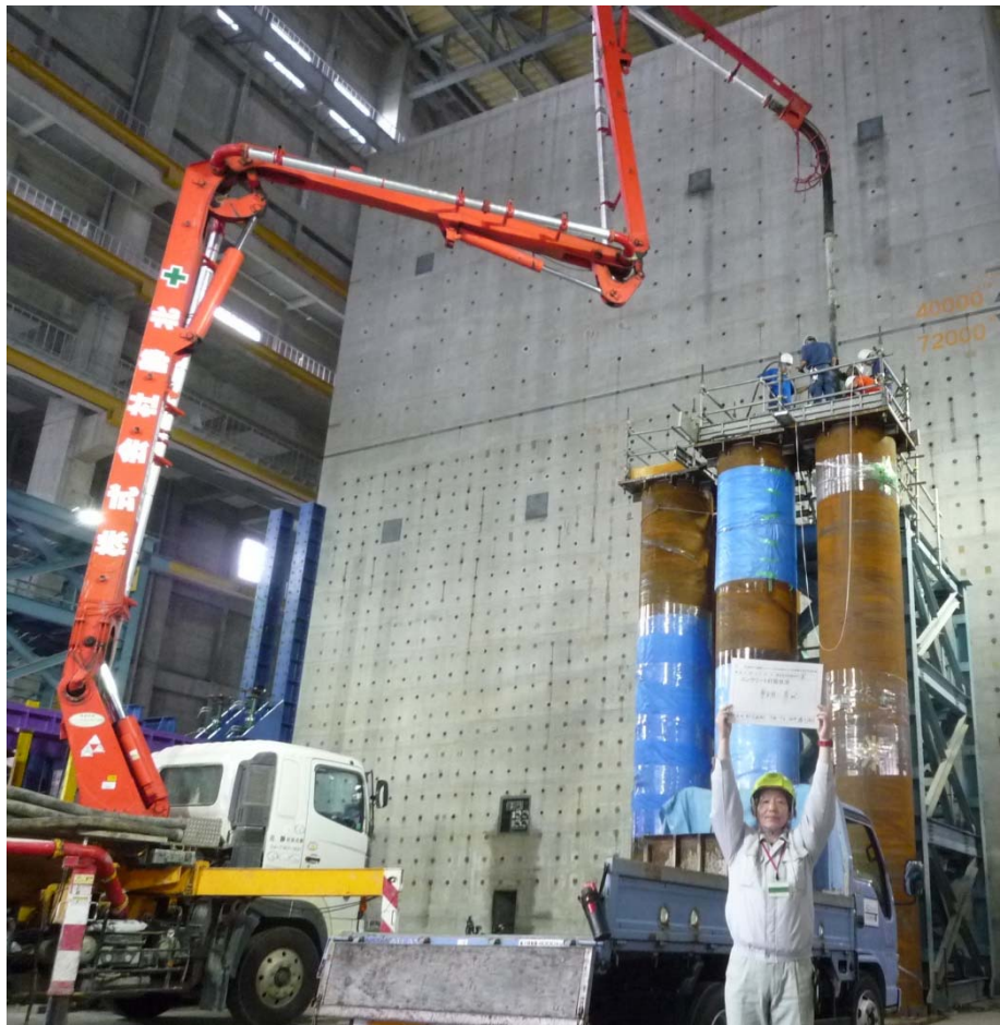
写真 6.3.7 コンクリート打設状況（建築研究所実大構造物実験棟内）
