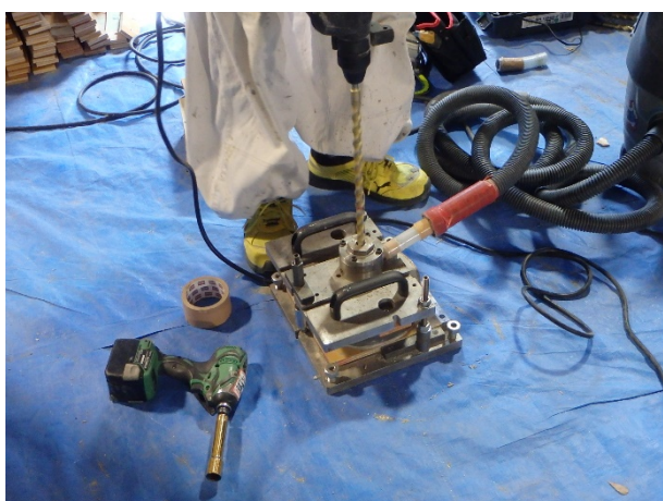
解図1 穿孔用治具の例
