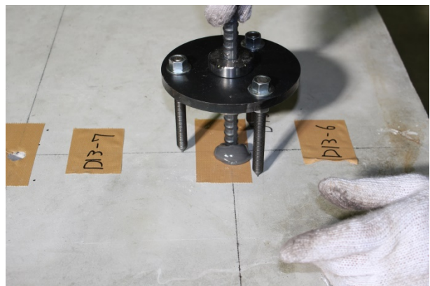
写真 2.2.3.1-4 アンカー筋の固着状況
