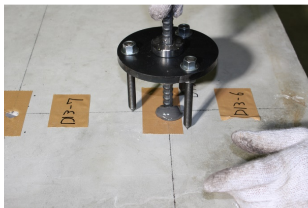
解図2 アンカー打設用治具の例
