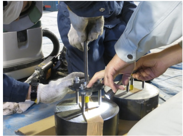
写真 2.2.2.1-4 アンカー筋の固着状況
