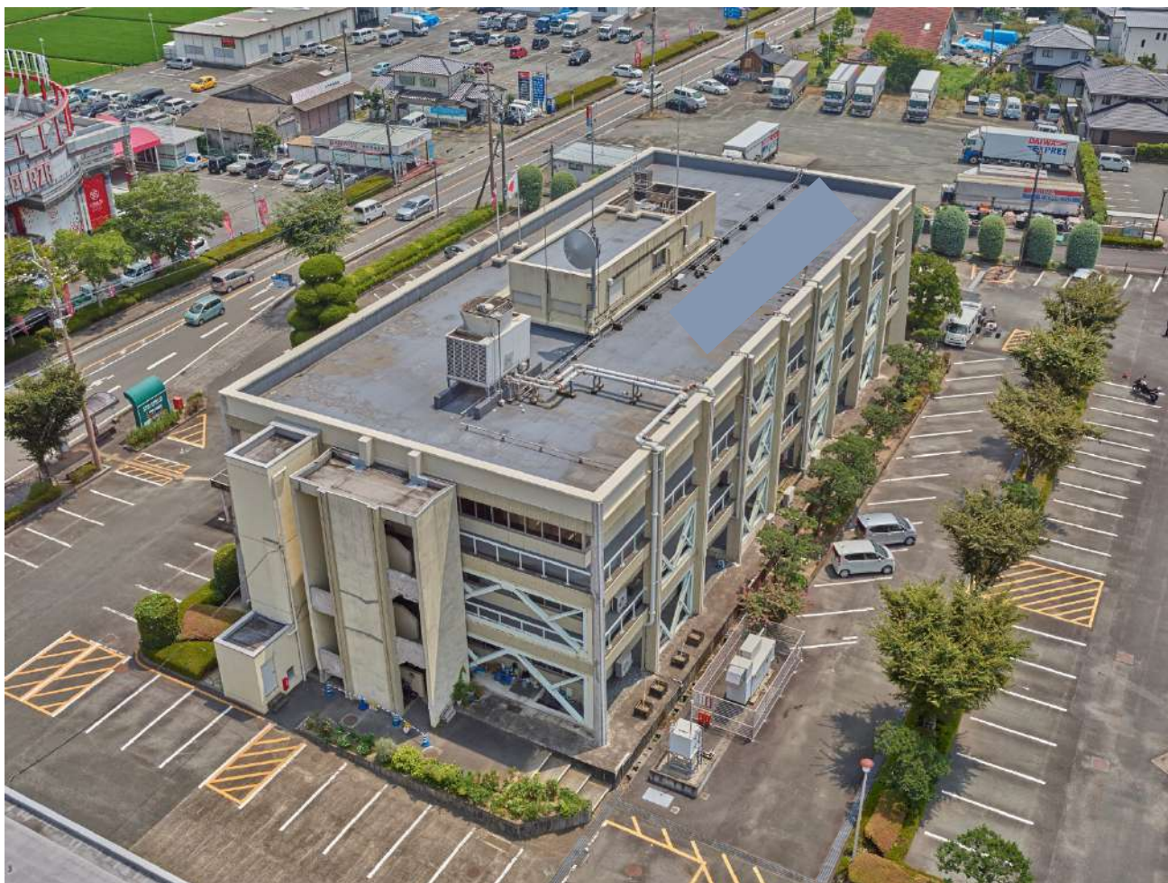
写真 8.4.3.2 ドローンによる建物全景写真
