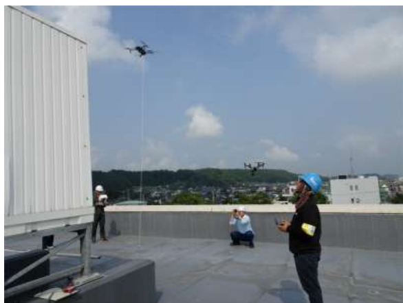
写真 8.4.3.24 ドローンによる計測の様子
