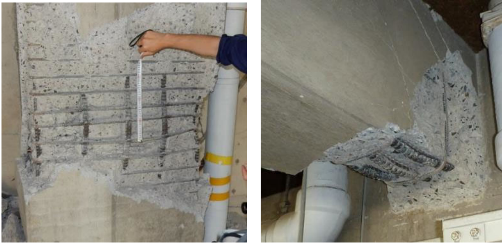
図 1.1.3-3 1階柱主筋, 2階大梁（張間方向）の配筋
