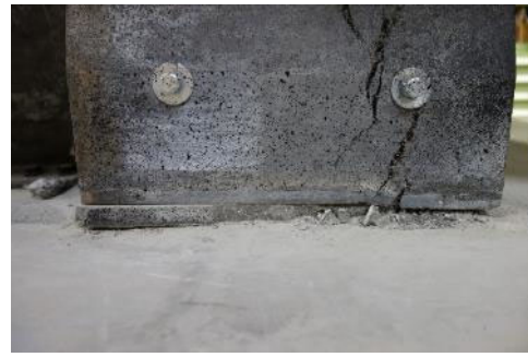
(i) 西面柱脚目地部
