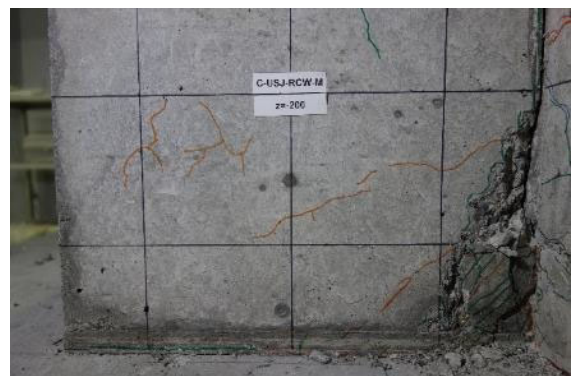
(f) 袖壁脚部コンクリート圧壊
