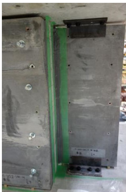
(b) 袖壁パネル接着
