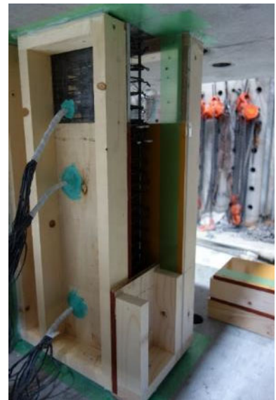
(c) 袖壁型枠設置
