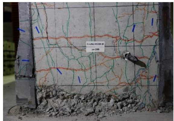
(d) 柱脚コンクリート圧壊
