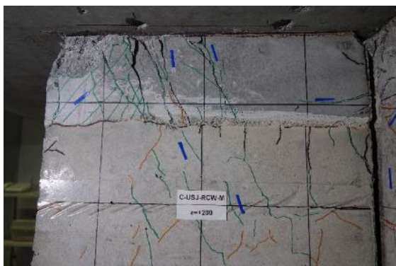
(e) 袖壁頂部圧壊およびせん断ひび割れ
