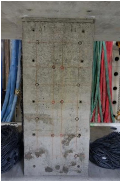
(a) アンカー打ち込み位置墨出し
