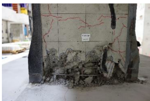
(g) 南面柱脚部
