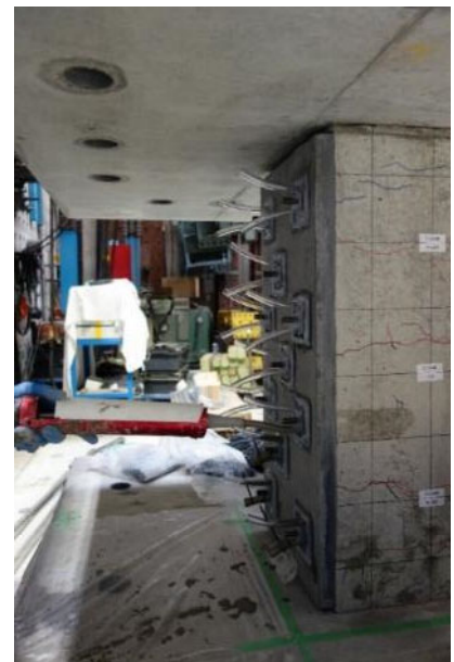
(f) 貫通孔へのモルタル充填
