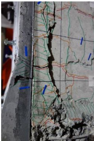
(e) パネル界面縦ひび割れ
