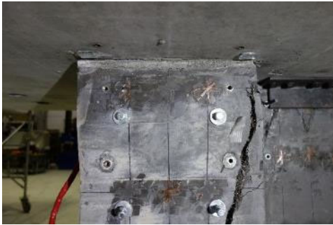
(j) 東面柱頭目地部
