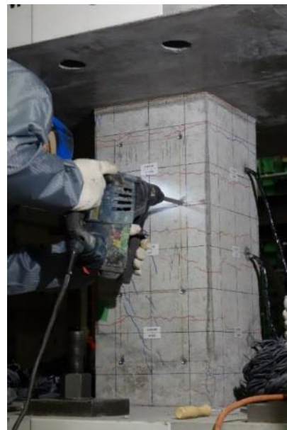
(b) アンカー打ち込み
