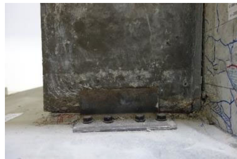
(m) 袖壁脚部目地部
