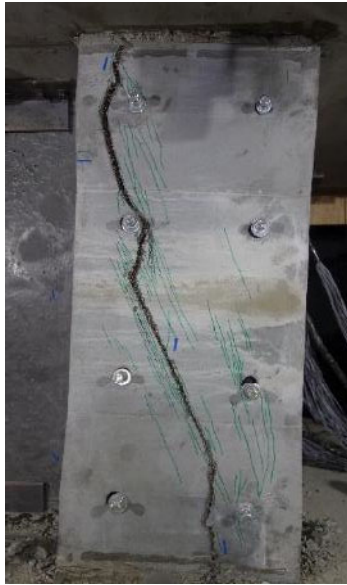
(a) 柱パネルせん断破壊
