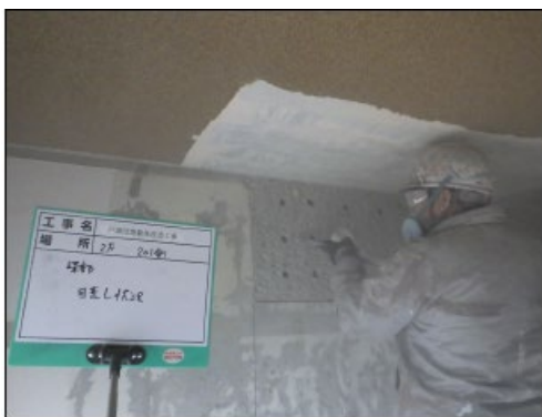
写真 8.2.2-11 補強梁用目荒らし状況
