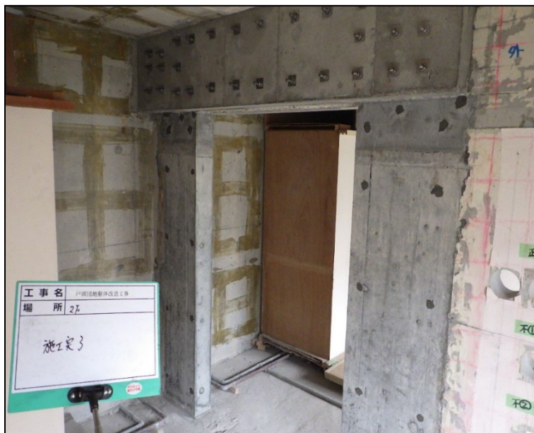
写真 8.2.2-47 躯体改造試験施工完了状況，全景，202 号室側
