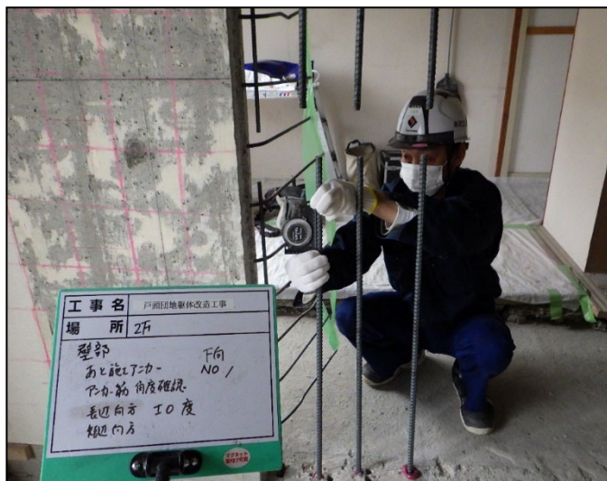
写真 8.3.2-11 アンカー筋の角度測定の状態
