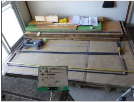
写真 8.2.2-21 補強梁用横筋寸法確認
