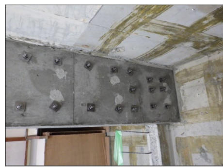
写真 8.2.2-32 補強梁コンクリート打設後
