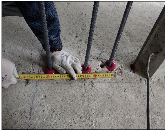
図 8.3.2-10 接着材の充填状況の確認(目視検査)
