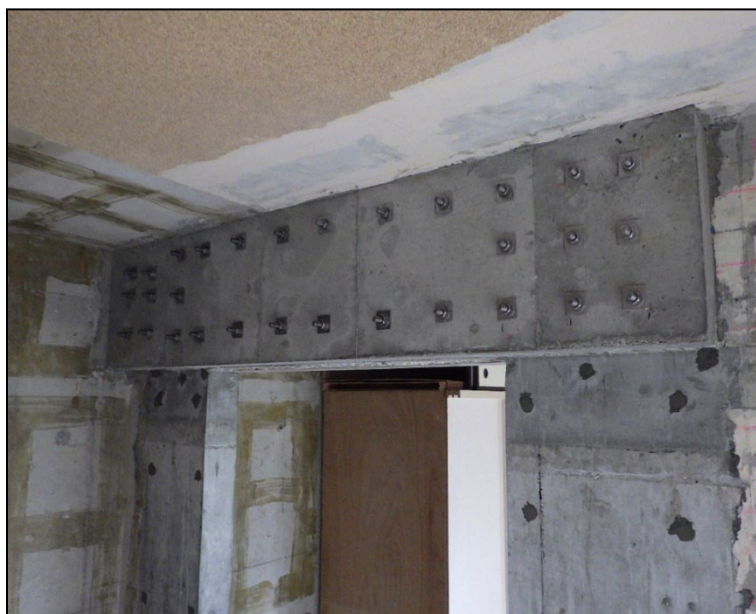
写真 8.2.2-48 躯体改造試験施工完了状況，外付け梁，202 号室側
