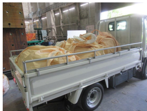
写真 8.2.1-10 発生材の処理
