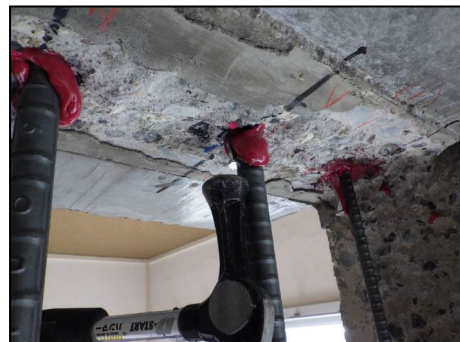
写真 8.3.2-9 くさび打込み状況 (上向き)
