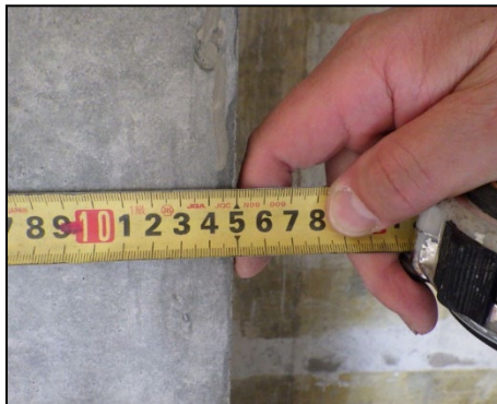
写真 8.2.2-63 北側補強壁柱厚さの確認
