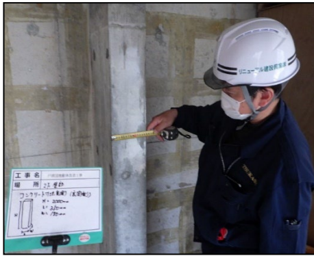
写真 8.2.2-61 北側補強壁柱厚さの確認
