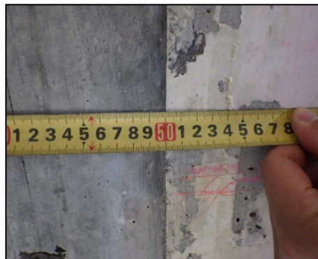
写真 8.2.2-66 北側補強壁柱の長さ確認
