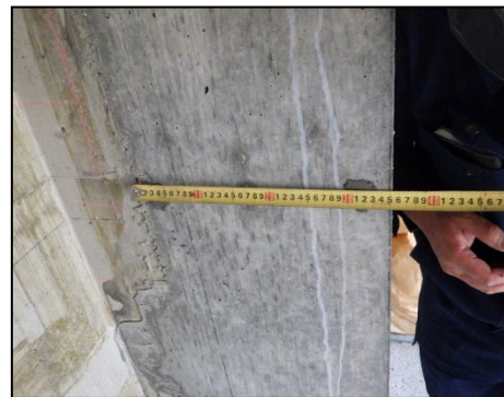
写真 8.2.2-59 北側補強壁柱の長さ確認
