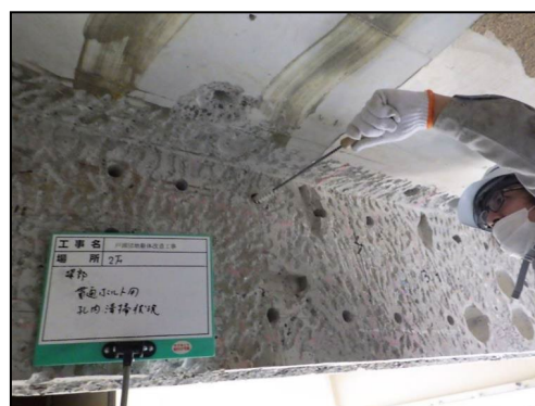
写真 8.2.2-12 通し筋の孔内の清掃
