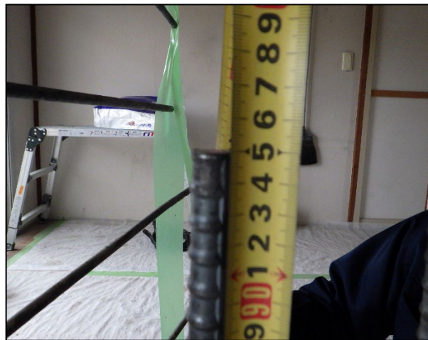
写真 8. 3. 2-30 あと施工アンカー施工後突出部測定状況，下向き No.1，近景 設計値:950mm，実測値 950mm
