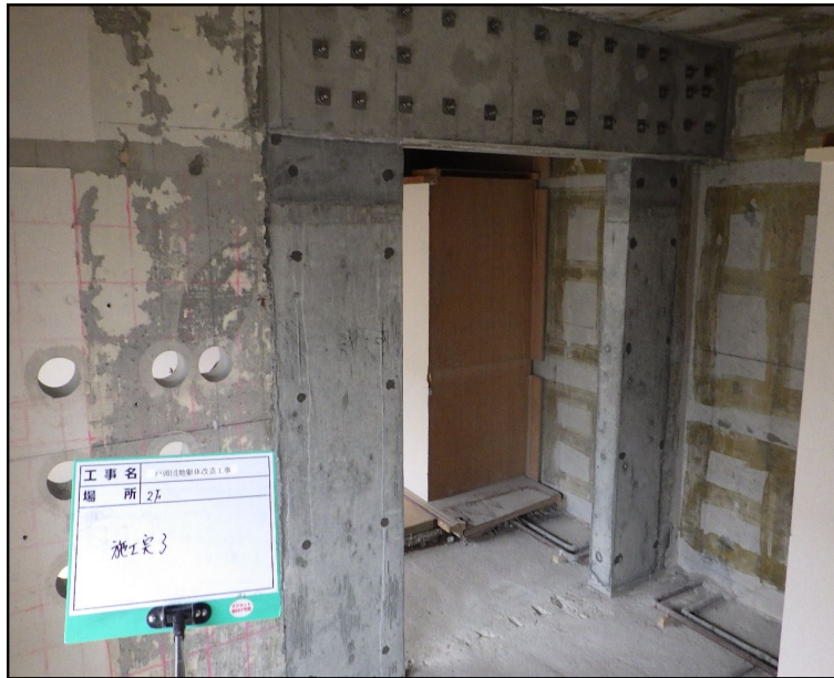
写真 8.2.2-45 躯体改造試験施工完了状況，全景，201 号室側
