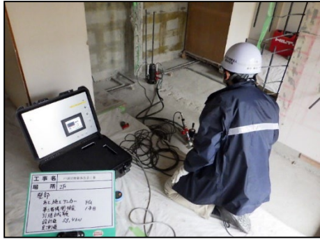
写真 8.3.2-17 あと施工アンカー施工 後試験，引張試験 (第三者機関による確認) (設計荷重 55.4kN)
