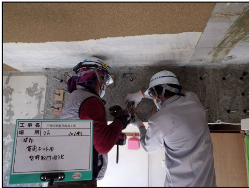
写真 8.2.2-17 通し筋用型枠設置状況
