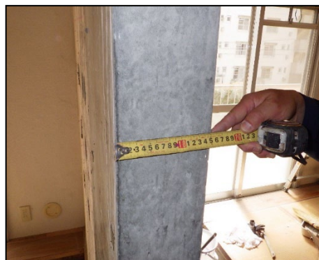
写真 8.2.2-68 北側補強壁柱厚さの確認
