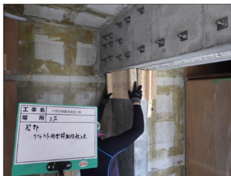
写真 8.2.2-43 壁柱補強部グラウト用 型枠
