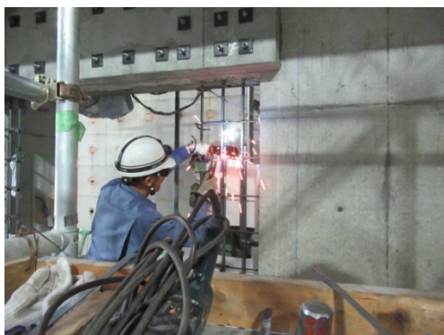
写真 8.2.1-17 横筋溶接
