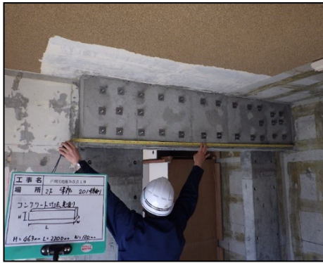
写真 8.2.2-55 外付け梁長さの確認, 201号室側
