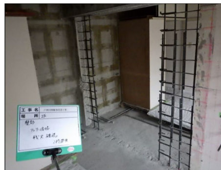
写真 8.2.2-40 壁柱補強部配筋
