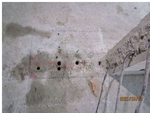
写真 8.2.2-38 あと施工アンカー穿孔の変更(下向きアンカー)状況
