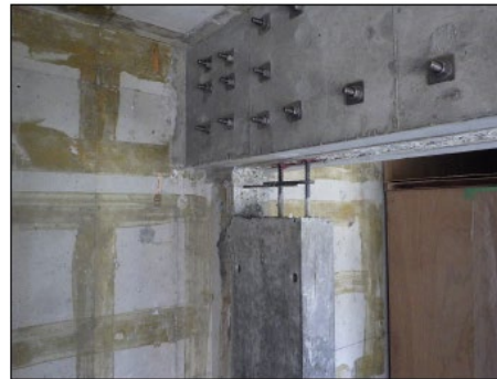
写真 8.2.2-42 壁柱補強部 コンクリート型枠脱型
