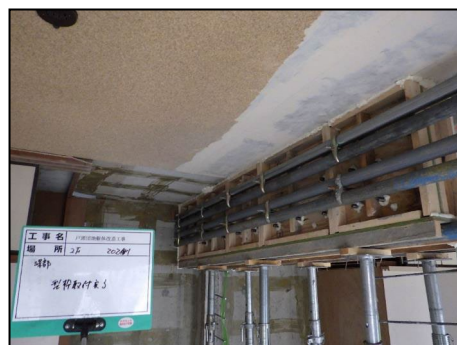
写真 8.2.2-26 補強梁設置状況
