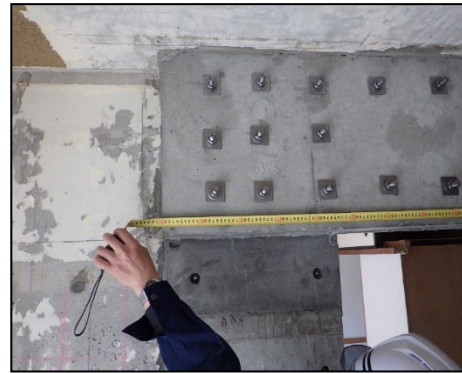
写真 8.2.2-56 外付け梁長さの確認, 201号室側
