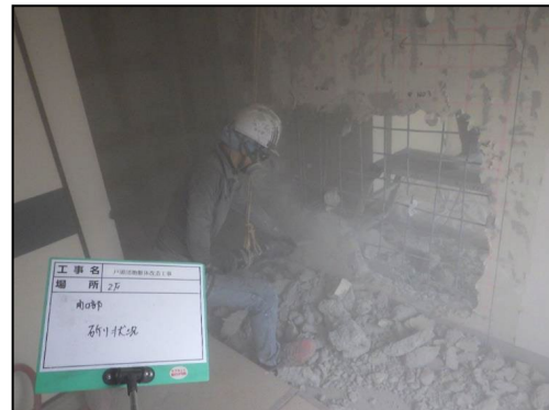
写真 8.2.2-8 開口部はつり状況
