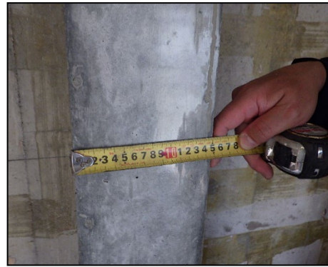
写真 8.2.2-62 北側補強壁柱厚さの確認
