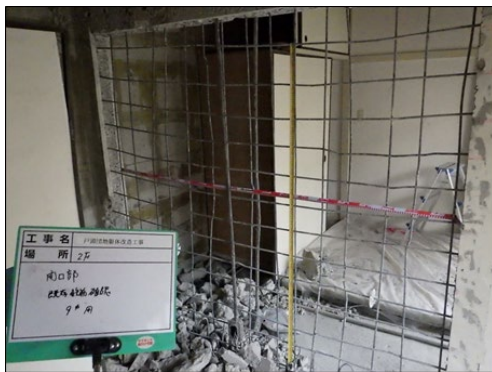
写真 8.2.2-9 開口部鉄筋はつり出し
