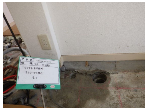
写真 8.2.2-4 コンクリート打設孔 (3階スラブ)
