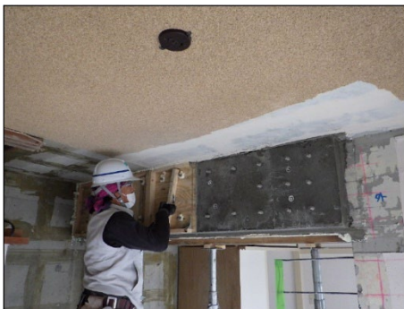
写真 8.2.2-31 補強梁脱型
