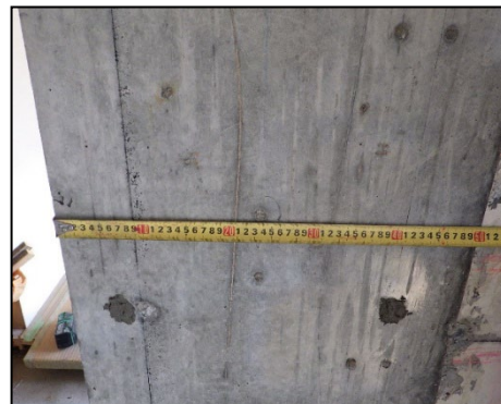
写真 8.2.2-65 北側補強壁柱の長さ確認
