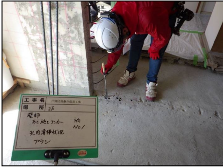
写真 8.3.2-4 孔内清掃状況
