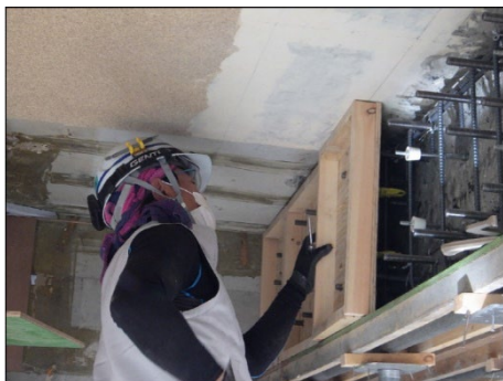
写真 8.2.2-25 補強梁型枠設置状況
