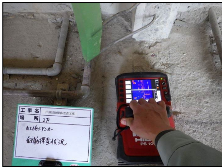
写真 8.2.2-33 既存鉄筋の探査
