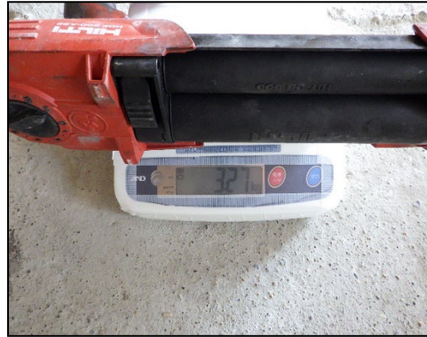
写真 8.3.2-22 樹脂測確認状況,近景 2階壁脚, No1 注入前, 3.27kg
