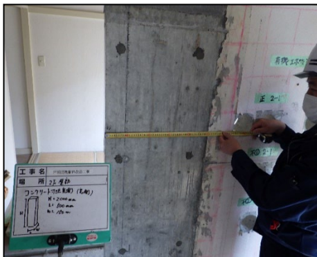
写真 8.2.2-64 南側補強壁柱の長さ確認
