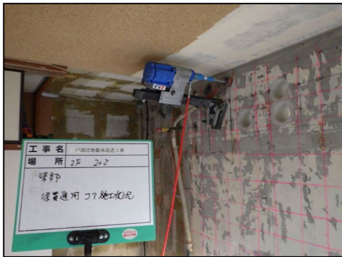
写真 8.2.2-1 通し筋用のコア抜き施工状況
