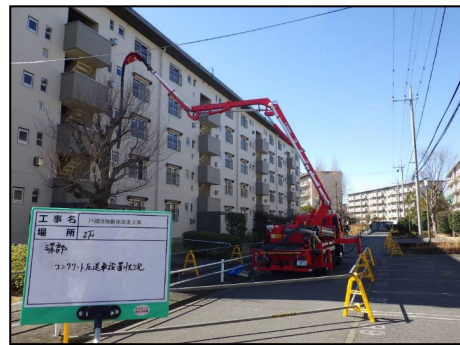
写真 8.2.2-28 コンクリート圧送状況
