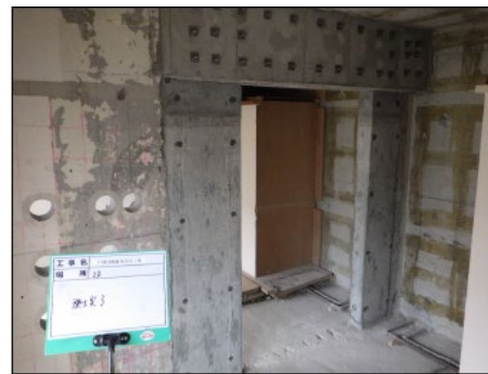
写真 8.2.2-44 壁柱補強部グラウト脱型後
