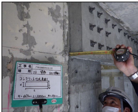
写真 8.2.2-52 外付け梁幅の確認, 201号室側
