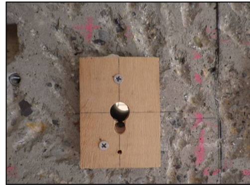
写真 8.2.2-18 通し筋固定用型枠設置状況近景
