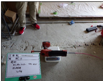
写真 8.3.2-23 樹脂測確認状況, 2階壁脚, No1 注入後, 3.15kg
