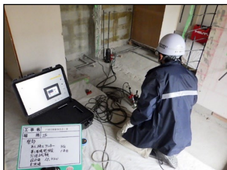
写真 8.3.2-13 あと施工アンカー施工後 試験，引張試験 (第三者機関による確認) (設計荷重 55.4kN)
