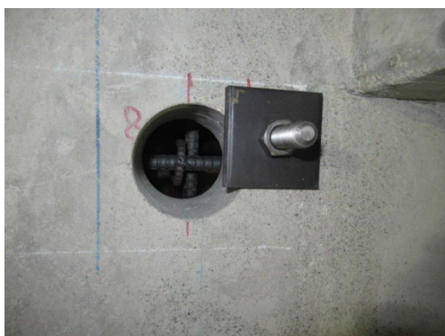
写真 8.2.1-15 打設用孔
