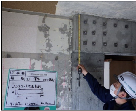
写真 8.2.2-49 外付け梁せいの確認, 201号室側
