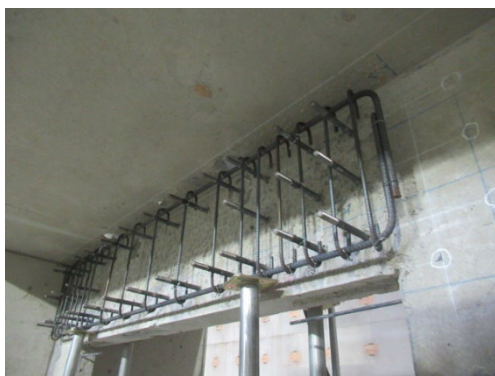
写真 8.2.1-13 壁梁配筋
