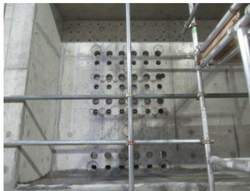
写真 8.2.1-4 コアボーリング後
