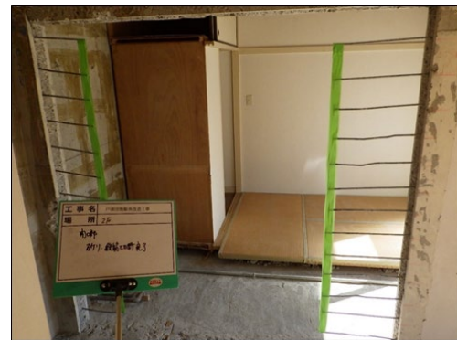
写真 8.2.2-10 開口部鉄筋切断・養生
