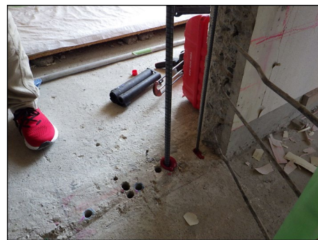
写真 8.2.2-38 あと施工アンカー接着用樹脂の充填状況（下向き）
