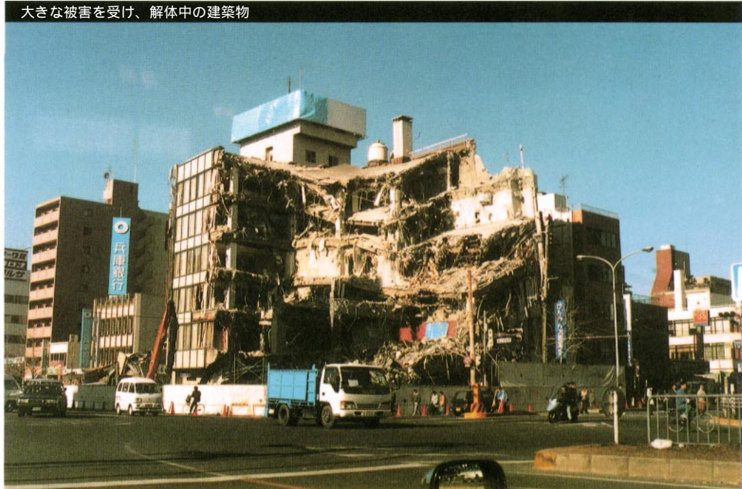
大きな被害を受け、解体中の建築物
