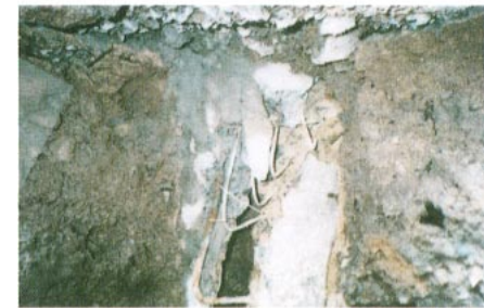
杭の破損例
