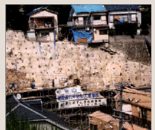
写真9:斜面の復旧対策(兵庫県南部地震)
