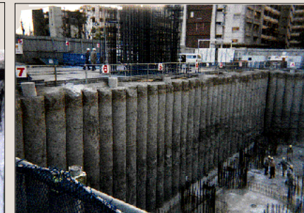
写真6:地盤改良による土柱 (東京都内:土留めに使用した例)
