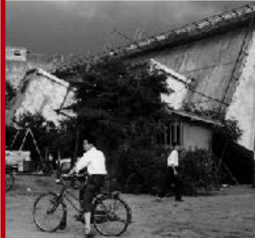
写真4:液状化によるアパートの転倒(新潟地震)
