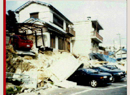
写真8:地震による住宅地の土砂災害(兵庫県南部地震)
