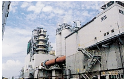
写真: エコセメント製造プラント (写真提供: 太平洋セメント株式会社) (主な構造部材にエコセメントコンクリートを使用)
