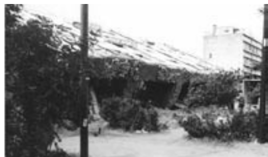
■ 写真1 1964年新潟地震で転倒したアパート 砂地盤が液状化し支持力を失い転倒した
