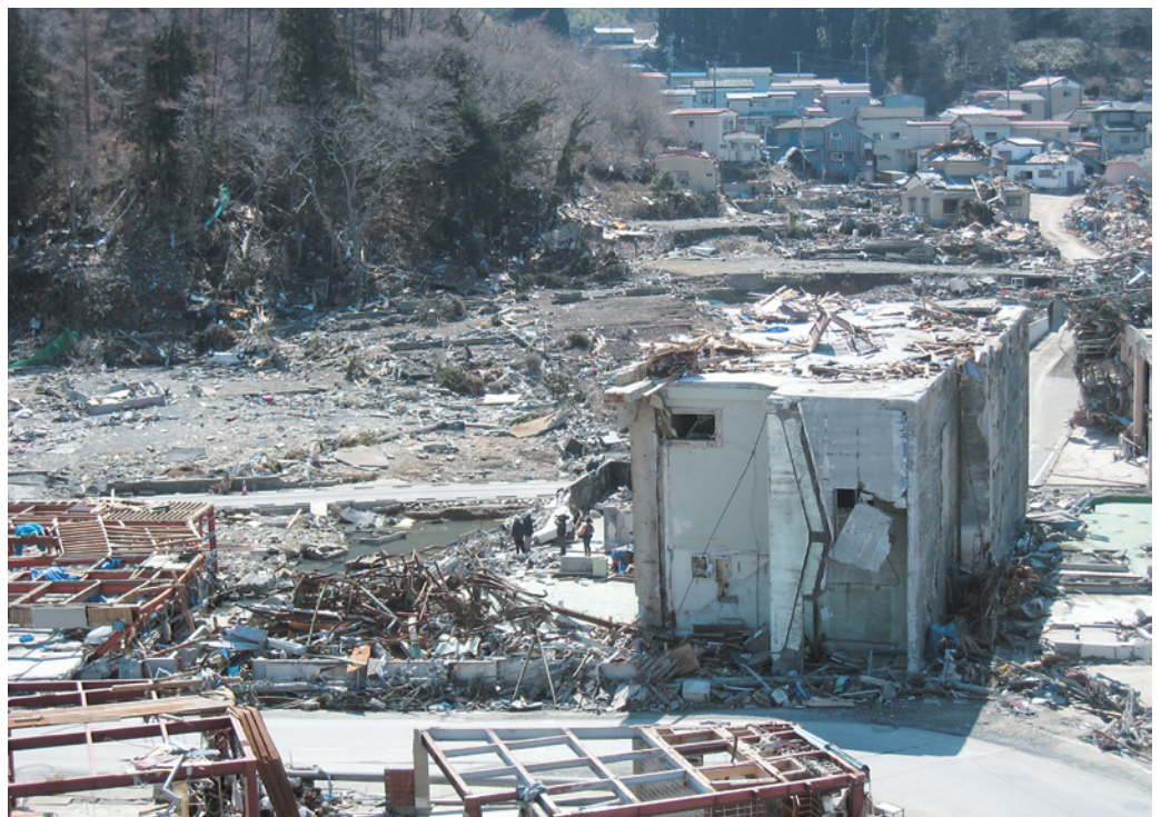
■写真1 津波被害（宮城県女川町）
