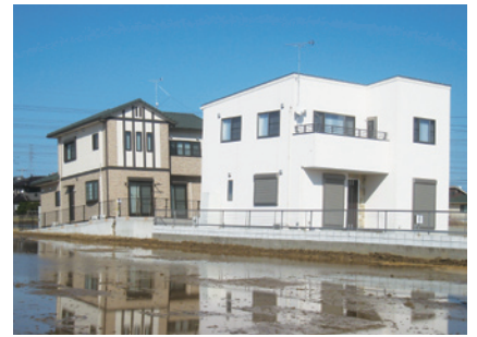
■写真10 液状化による傾斜
