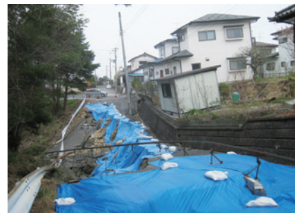
■写真11 高台の端部斜面の地すべりによる被害
