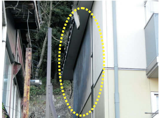
■写真4 焦げた隣棟外壁
