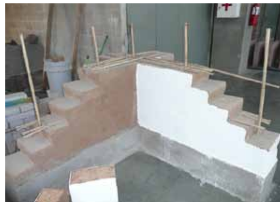
■写真5 アドベ壁の展示用モデル(組積体(アドベ)の間に竹のような素材を挟むことで補強されている)
