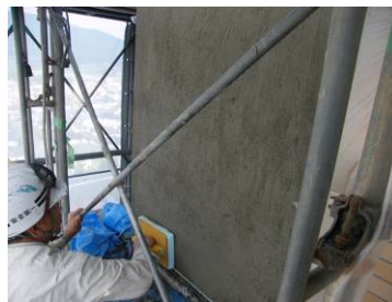
写真-5.21 こて仕上げ
