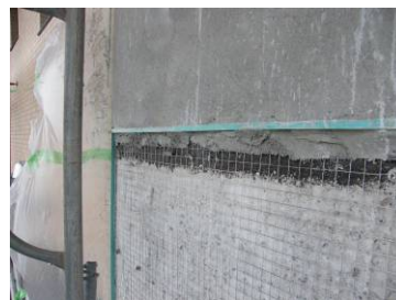
写真-5.23 目地部での塗り継ぎ
