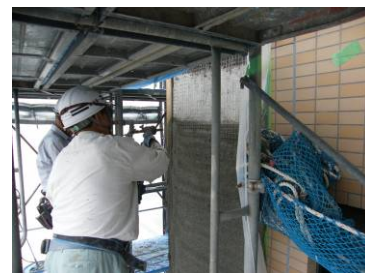
写真-5.17 吹付け施工
