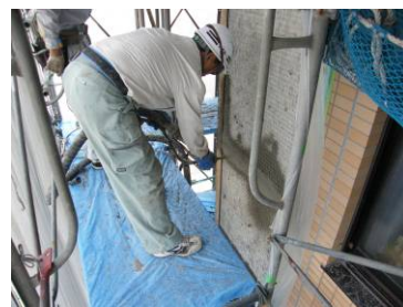
写真-5.15 吹付け施工
