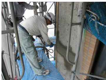
写真-5.16 吹付け施工
