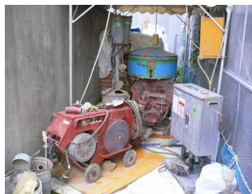
写真-5.7 機材の設置
