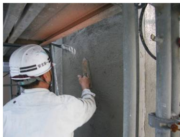
写真-5.20 こて仕上げ
