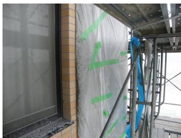
写真-5.24 養生(一例)
