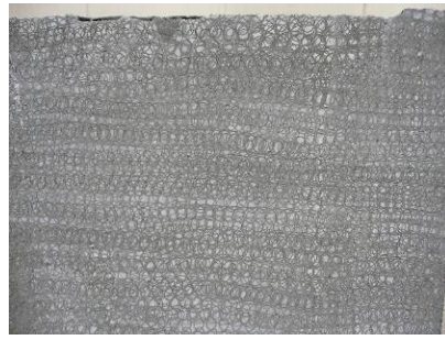
写真-5.2 超高压洗浄(例)
