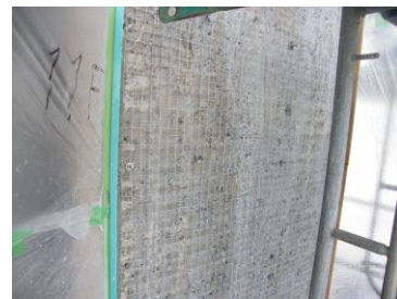
写真-5.6 吸水調整材塗布後
