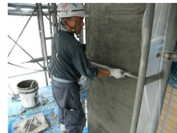
写真-5.19 定木ずり
