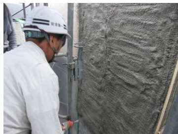
写真-5.18 吹付け施工
