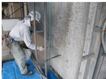
写真-5.5 吸水調整材塗布
