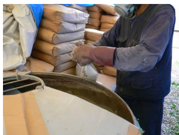
写真-5.10 混和液の投入
