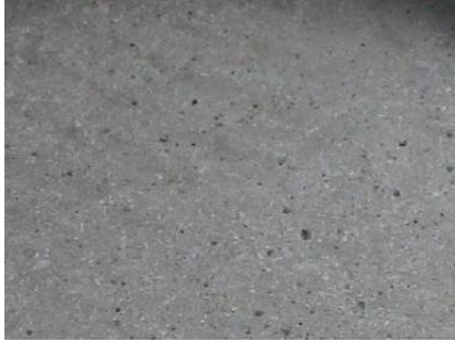
写真-5.1 目荒し後下地状況
