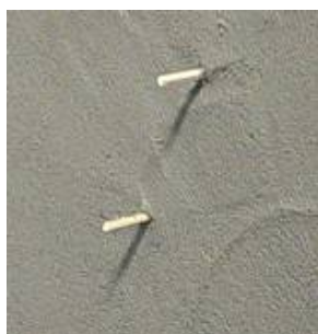
写真-6.1 アンカー孔養生
