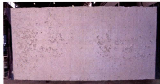
写真1 No.1(無補修)実験後の状況
