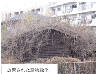
放置された建物緑化
