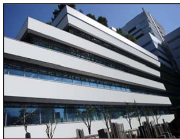
写真 2-33 壁面緑化 (見かけ上 400 m 2 )
