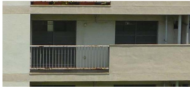
写真 5-1 ベランダに面した壁面
